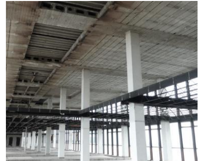
Afb. 25 Ontmanteld gebouw, zicht op flexibele staalstructuur (Team V Architects, 2020).
