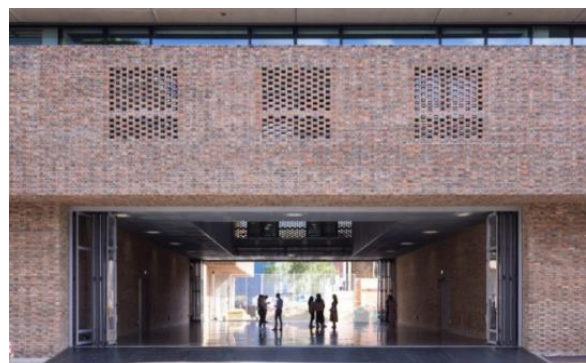
Afb. 96 Buitenzicht 'hangaar' (Iwan Baan).
