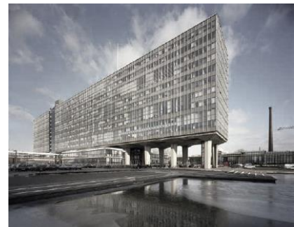
Afb. 20 Hoofdgebouw voor renovatie (Colenbrander & Huiskamp, 2019).
