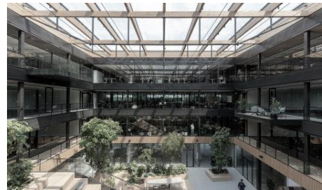
Afb. 17 Zicht op de houten kapconstructie in het atrium (Ector Hoogstad, z.d.).
