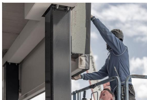
Afb. 16 Plaatsing prefab gevelelementen NEXT (Kingspan, z.d.b).
