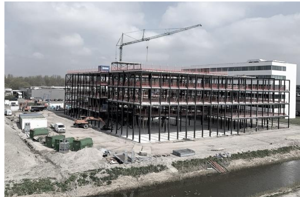
Afb. 14 Staalstructuur NEXT Delft (Schulte & Lestrade, 2022).
