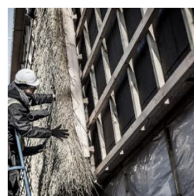
Afb. 45 Plaatsen cassettepanelen (Passivhaus Trust, 2014a).
