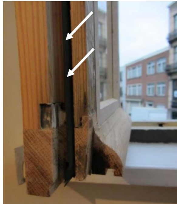
Figuur 4: Aangebrachte sponning aan binnenzijde (2) (Frederik Mahieu, 2017)
