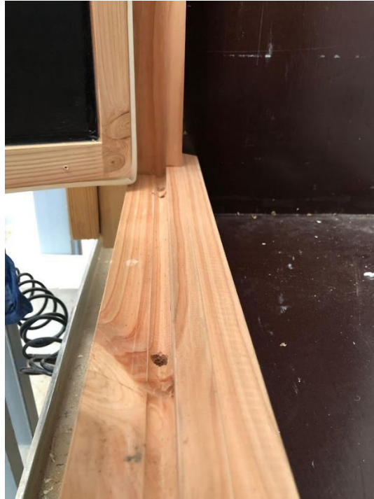
Figuur 31: Afvoergoot onderregel
