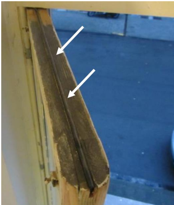
Figuur 3: Aangebrachte sponning op buitenzijde (1) (Frederik Mahieu, 2017)
