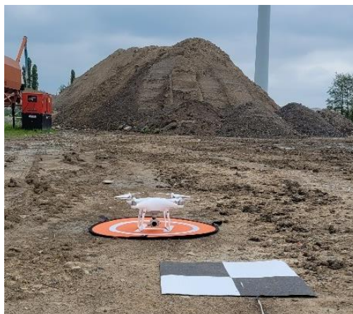
Figuur 34: Landingsplatform bij volume 1
