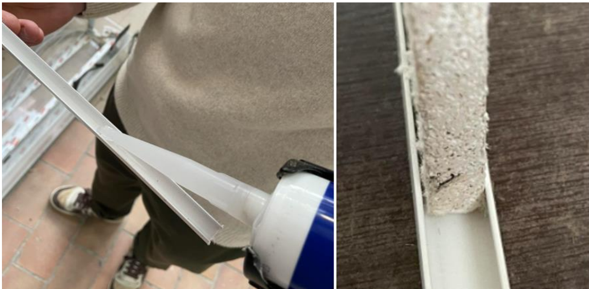
Figuur 12: Aanbrengen van silicone en bevestigen van U-profiel
