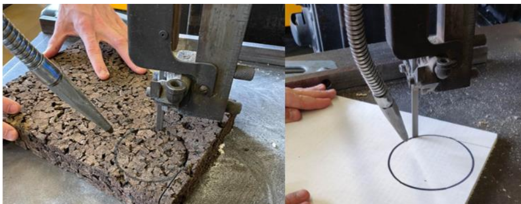
Figuur 25: Op maat zagen van kurkisolatie en magnesiumoxideplaat
