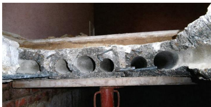
Figuur 53: Doorsnede welfsels beton Malem 1955 (Desmeyer, 28/04/2023)
