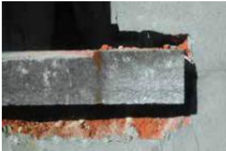
Figuur 19: Dorpel vrijgemaakt van het metselwerk (FCRBE, 2021e)
