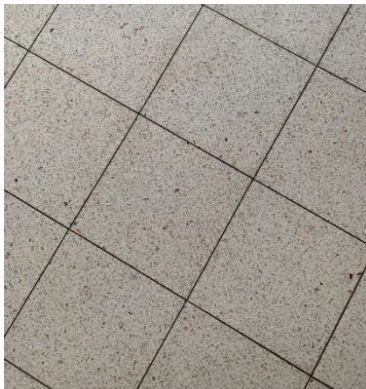
Figuur 26: Cementtegels Tijbaartstraat 6
