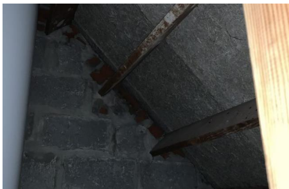
Gordingendak met kepers Dakisolatie dubbele laag
