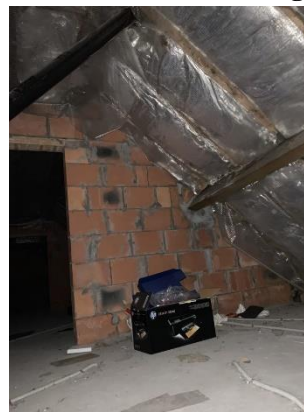
Gordingendak met kepers Dakisolatie enkele laag
