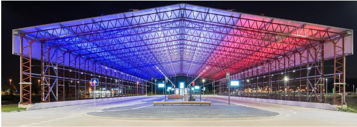
Figuur 13: Nieuwe busterminal met onderdelen van een vliegtuighangar uit WO II (Opalis, 2023g)
