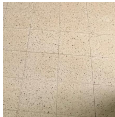
Figuur 27: Cementtegels Aarseleweg 34
