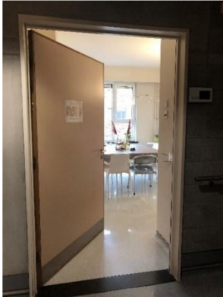
Foto 7: Deur van de ontbijtruimte
