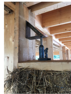
Figuur 30: Post and beam structuur strobalenwand (foto genomen door: Woonder en Architectengroep Barchi) xxix xxx
