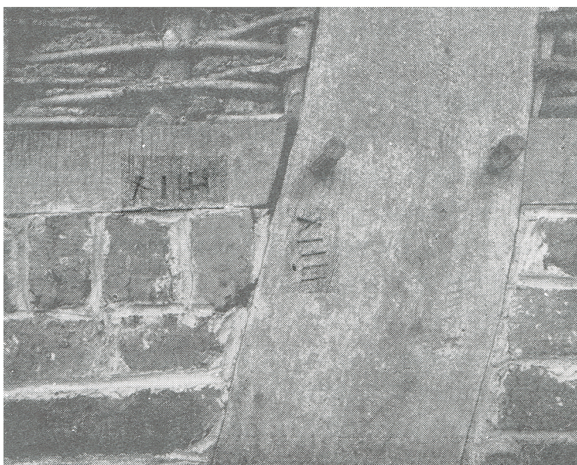
Fig.9: Genummerde onderdelen in het vakwerkskelet, Po- peringe
