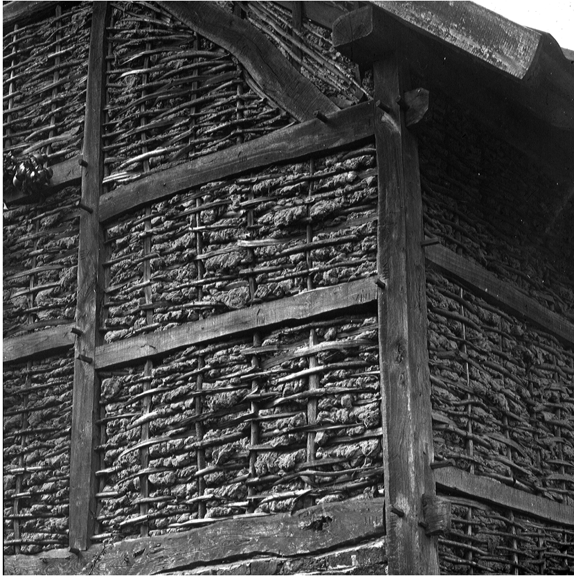
Fig.10: Invulwand uit vlechtwerk
