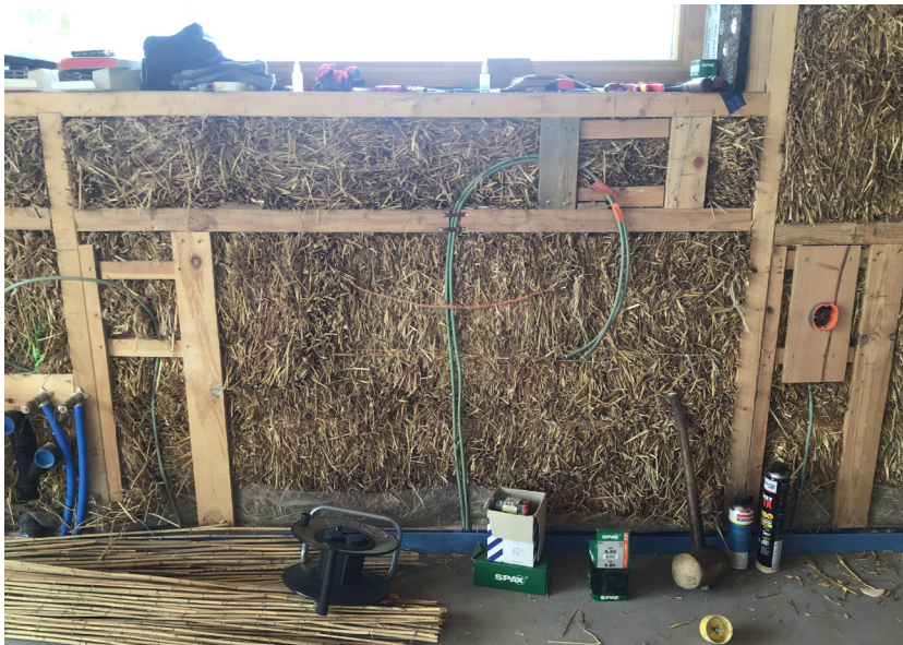
Fig.70: Wand D: binnenkant
