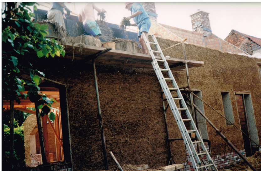
Fig.56: Wand C: constructie
