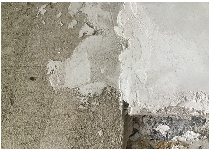
Fig.40: Wand B: 3 pleisterlagen, binnen
