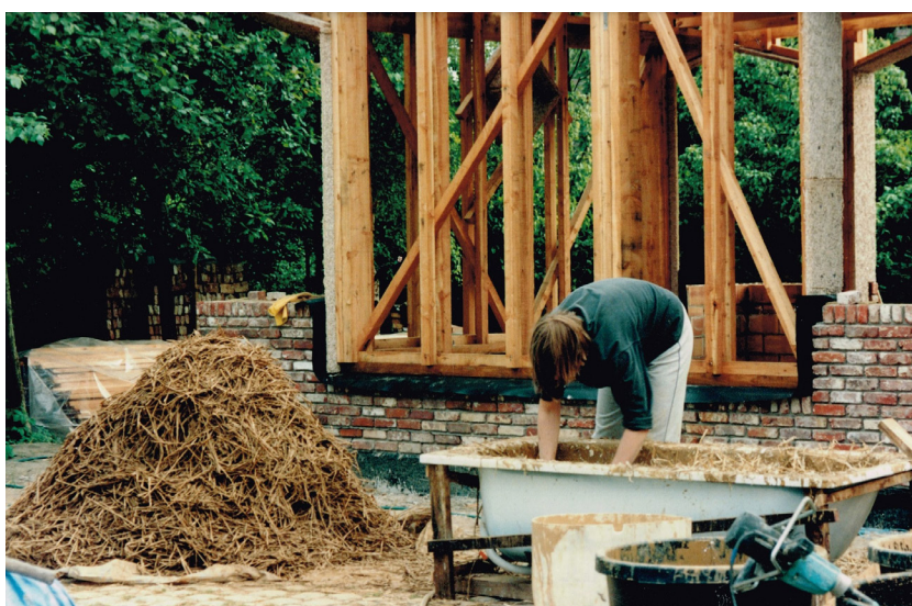
Fig.55: Wand C: constructie
