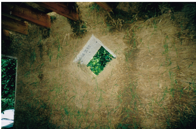
Fig.58: Wand C: uitdrogen van de wand
