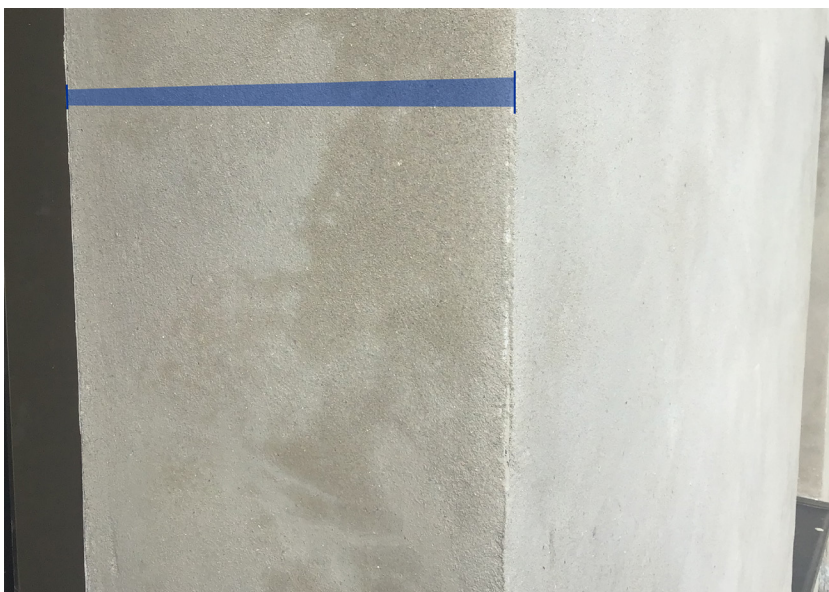
Fig.37: Wand B: detail afwerking
