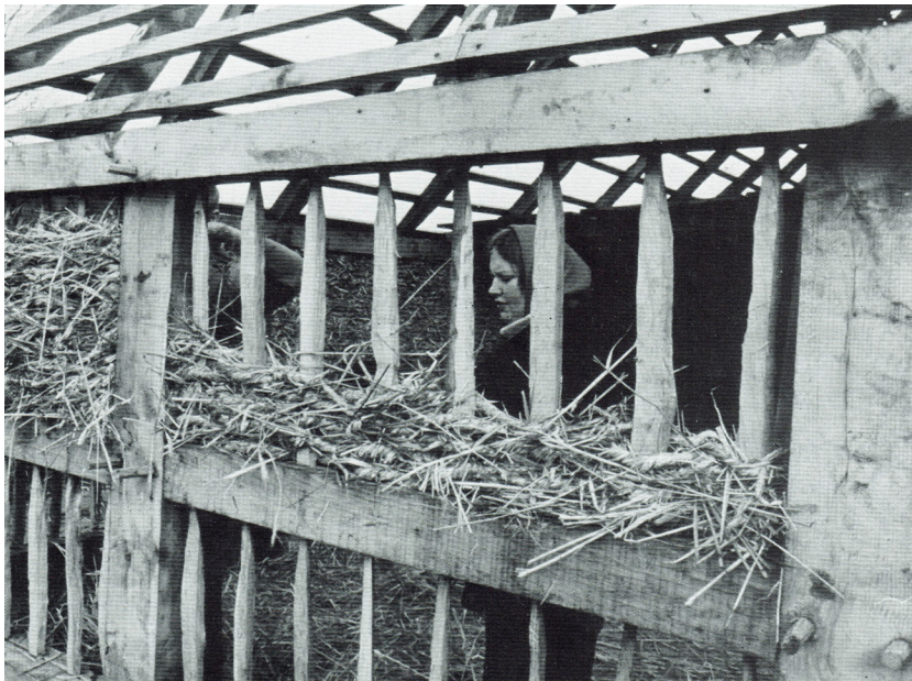
Fig.11: Invulwand uit vlechtwerk
