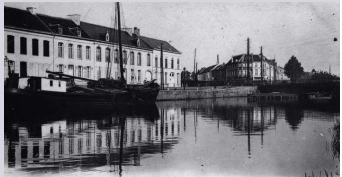
Figuur 12: Eerste spoorwegbrug over de Dender
