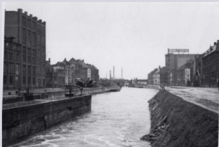
Figuur 33: (1940) We zien links de Van Wambekekaai met waardevolle industriële architectuur. De Industrie is aanwezig maar staat naast woningen en zit verscholen achter geornamenteerde bakstenen gevels. (Hoogste deel van Glucoserie Réunion)
