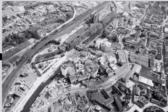
Figuur 52: (2013) De Dender is gedempt, de straten en kaaien ontoegankelijk en het eiland overwoerd met moderne industrie. De dichtheid van de cluster is absurd. Het stadsdeel sluit zich af van de rest van de stad.
