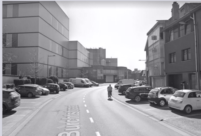
Figuur 48: (2021) Het authentieke 'SASA'-gebouw hoort bij het industrieelcomplex van Tereos. Het is overwoekerd door moderne industriegebouwen. Er is veel autoverkeer en parking langs beide kanten van de straat.
