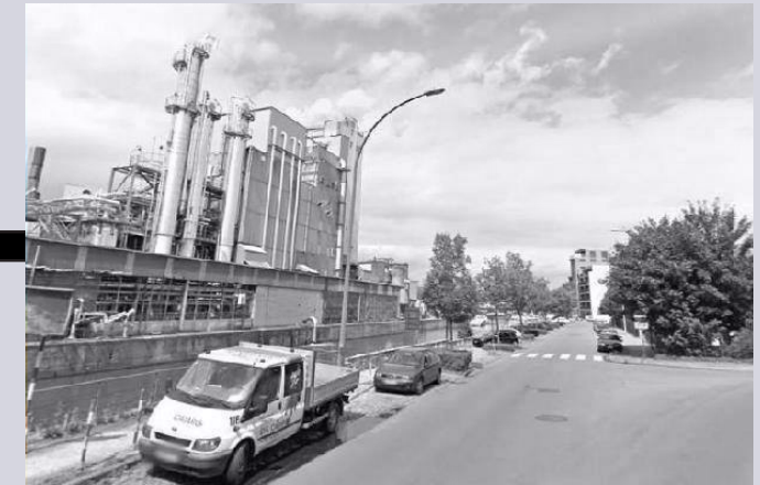
Figuur 29: (2021) In de verte zien we nog steeds de sluis. De van Wambekekaai is eigendom van Tereos en Chipka is overwoekerd met moderne fabriekstorens. Rechts zien we de recent heraanlegde kaai en het Werfplein (ter hoogte van waar vroeger de Dender splitste).
