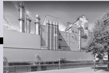
Figuur 35: (2021) We zien links de sluis. Rechts staat nog steeds het gebouw 'De Wolf - Cornelis'. Dit gebouw is zichtbaar op de foto uit 1940.
