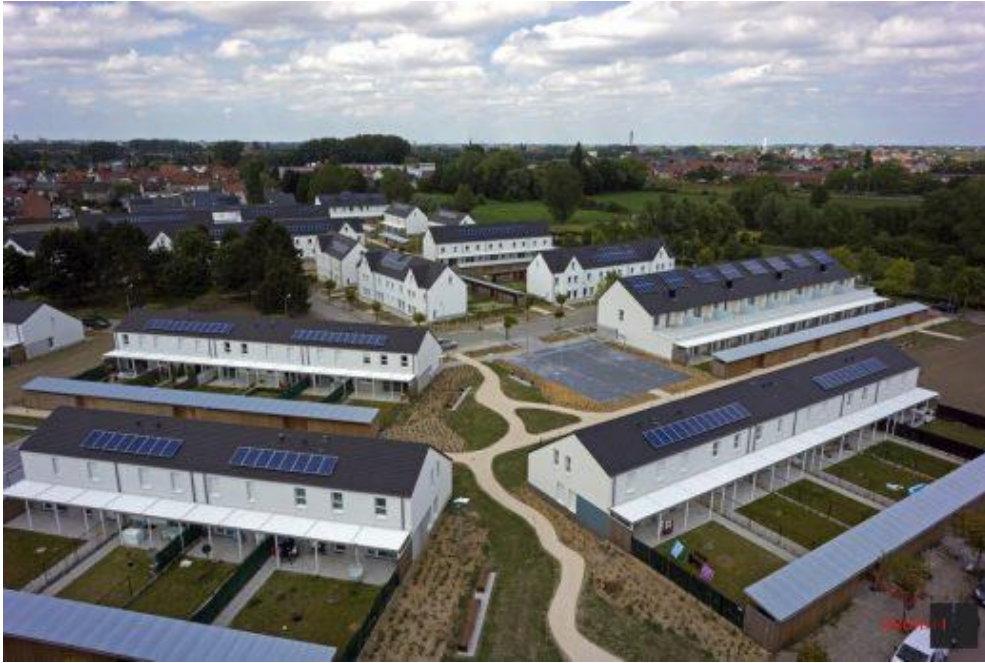
Figuur 9. De wijk Venning na renovatie (Intercommunale Leiedal, p.23, 2011)
