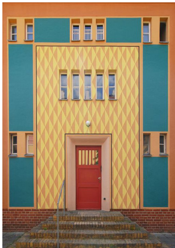
Fig. 31. Beschildeerde en gekleurde facade in de tuinstad Falkenberg door Bruno Taut
