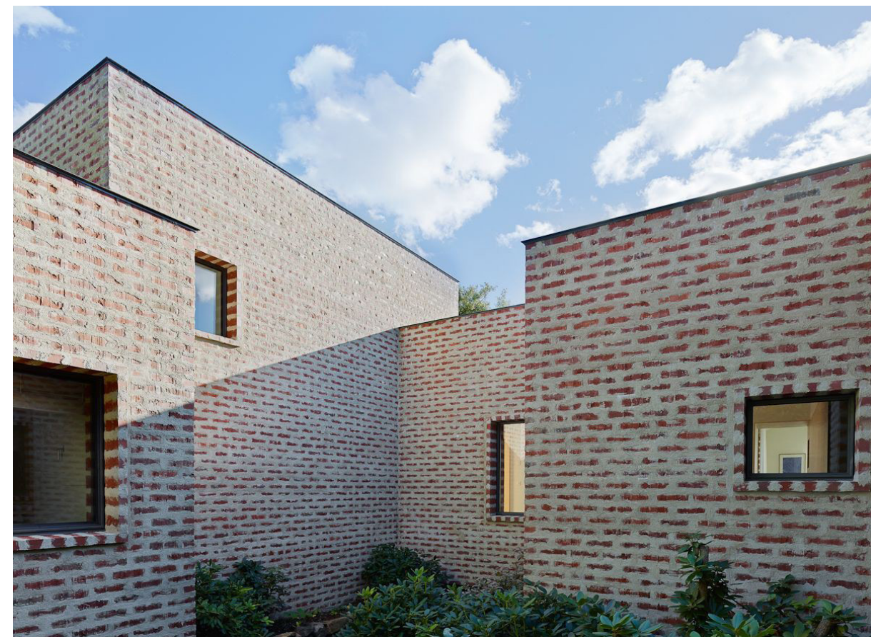
Fig. 119. Het overvloedige voegwerk vlak de gevel af en geeft het een veel lichtere verschijningskleur dan wanneer diepe groeven zouden zijn gebruikt.
