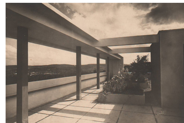
Fig. 29. Zwart-wit foto van dakterras van Le Corbusiers woning in de Weißenhofsiedlung.
