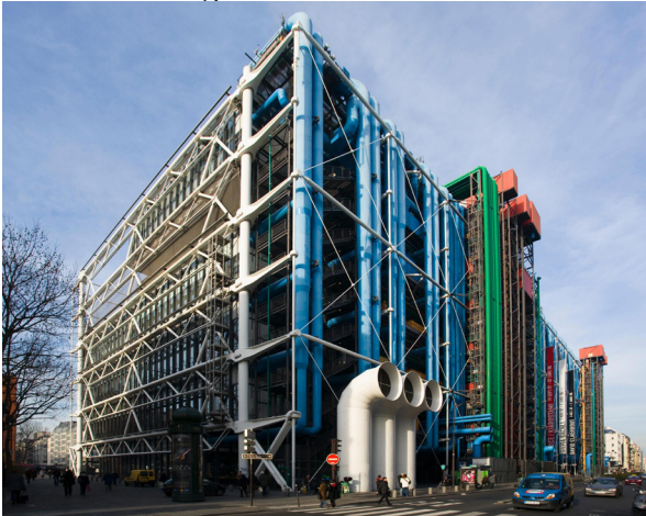
Fig. 9. Het 'binnenstebuiten gedraaide' Centre Pompidou toont de functie van de technieken aan de hand van kleuren-codes gebaseerd op de Britse standaard.
