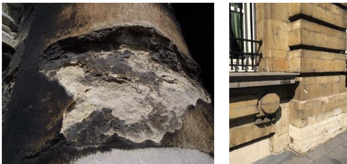
Figuur 2.6: Vorming van gipskorst op Ledesteen (links) en vorming van een patinalaag op Ledesteen (rechts) (Monumentenkennis, 2015).
