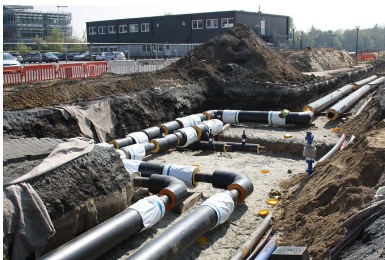
Figuur 39: thermische bocht in het warmtenet [43]
