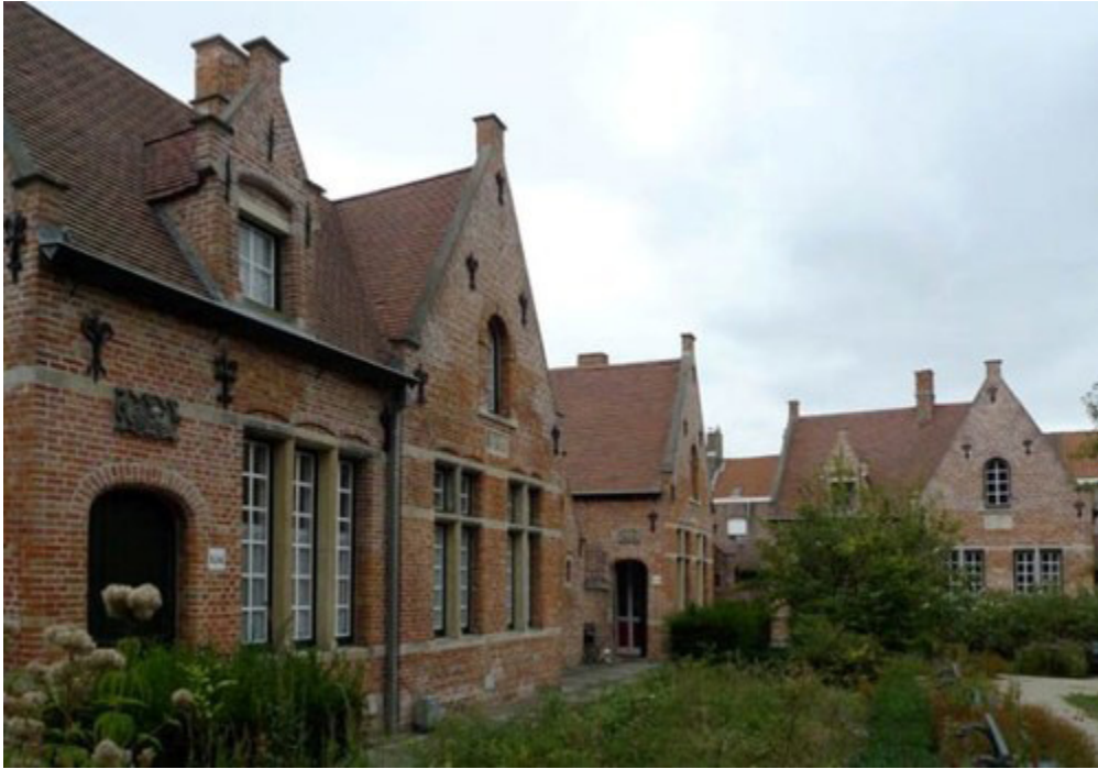
Figuur 45: gevelbeelden Godshuizen, Brugge [55]
