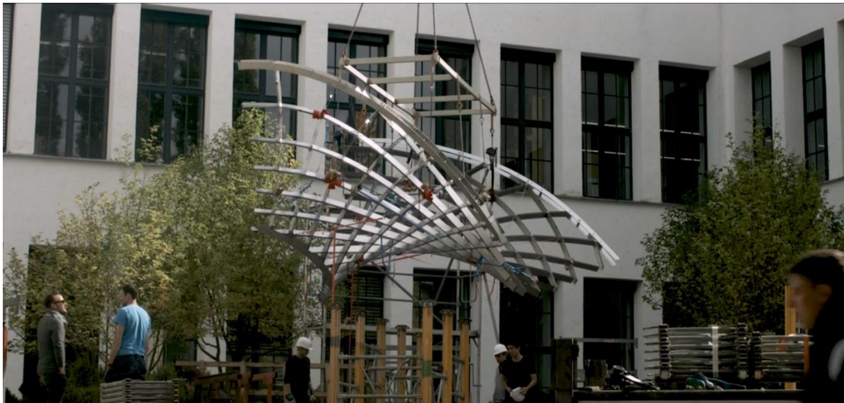
Figuur 8-7: Een van de negen segmenten tijdens de opbouw (bron: Felix Noe)
