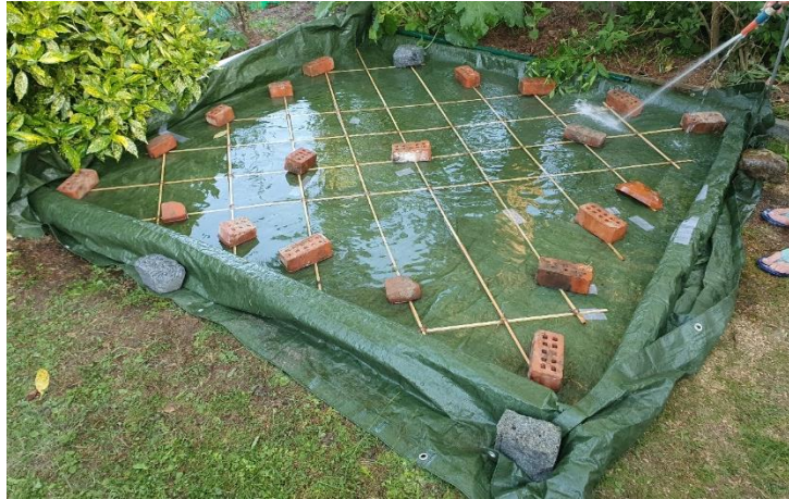
Figuur 6-60: Bevochtigen van het latwerk
