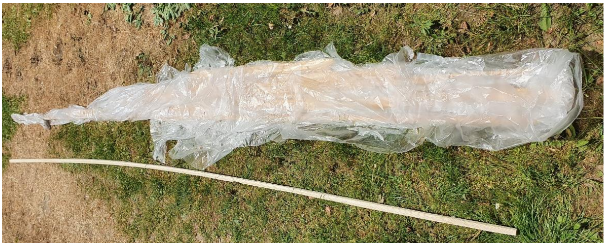
Figuur 6-51: Weken van de latten in folie
