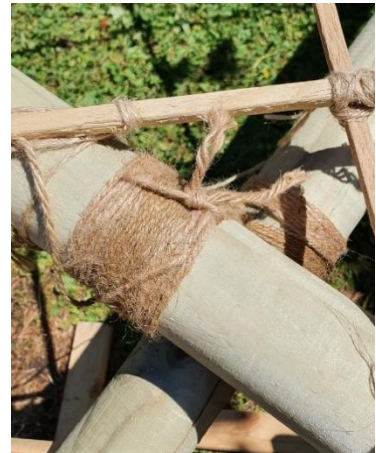
Figuur 6-74: Uiteenspatten van de ringbalk
