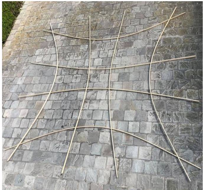
Figuur 8-27: Vlak latwerk voor het erectieproces
