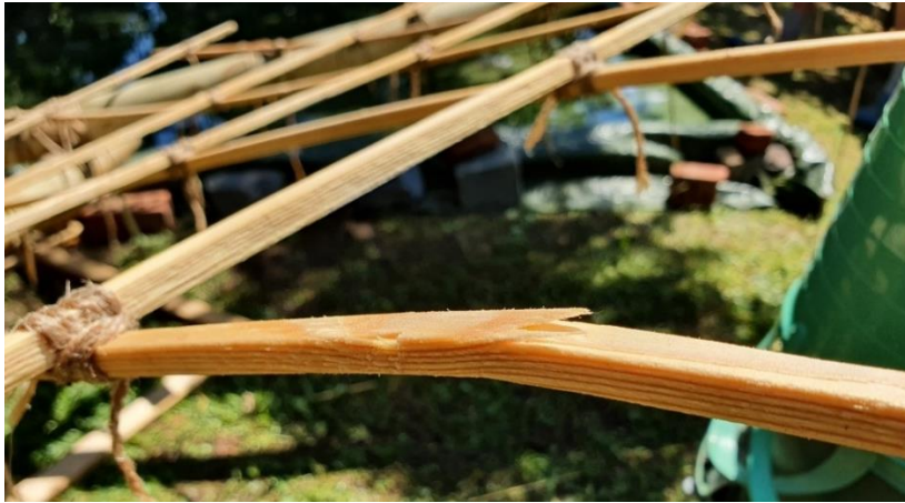
Figuur 6-73: Breuk van de latten ter hoogte van vezelonderbreking
