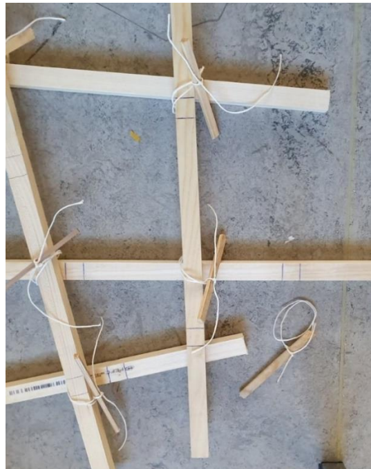
Figuur 7-23: Detailfoto van de sjorverbindingen met aangeknoopte hefboomsarm
