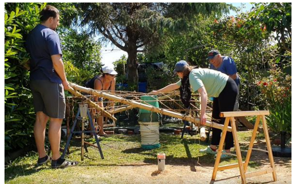
Figuur 6-70: Aanduwen van het centraal punt
