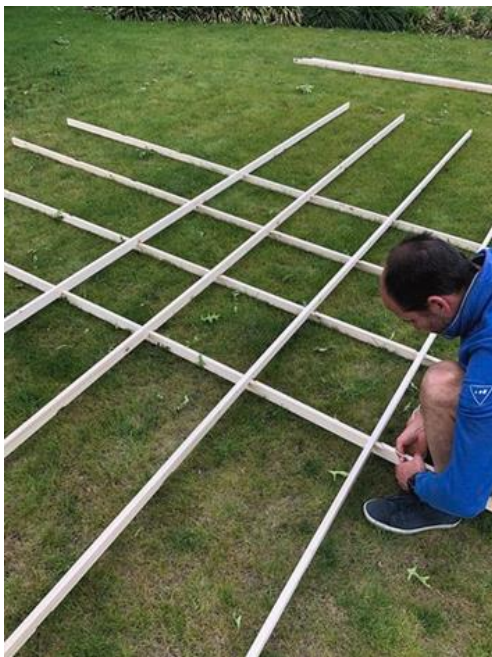
Figuur 8-32: Montage van het latwerk
