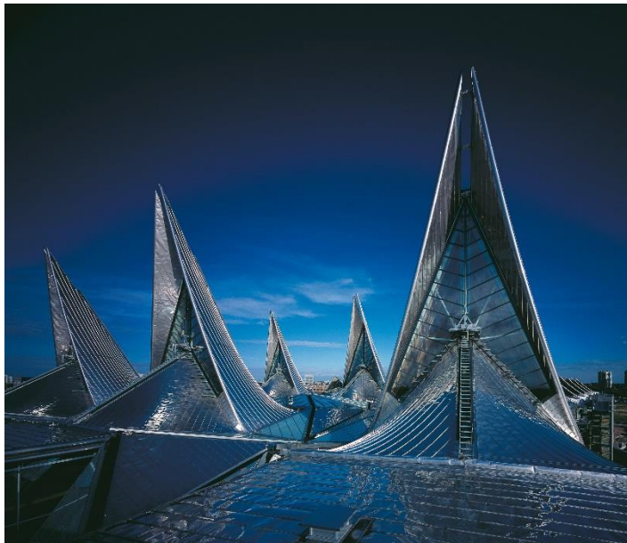
Figuur 7-5: Gerechtsgebouw Antwerpen (bron: Regie der Gebouwen)
