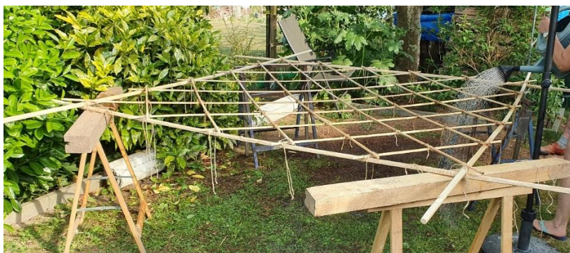
Figuur 6-55: Montage van het latwerk
