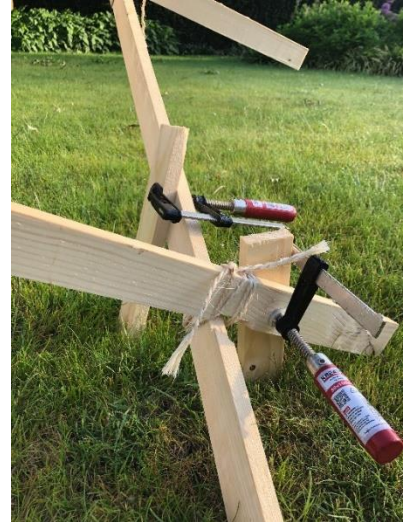
Figuur 8-35: Houten piketpalen met spanvijzen
