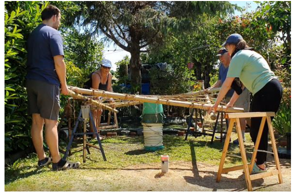
Figuur 6-68: Laten zakken van de onderste hoekpunten
