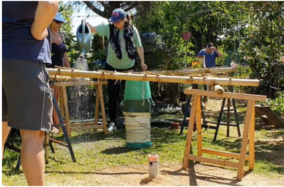
Figuur 6-67: Bevochtigen van het latwerk
