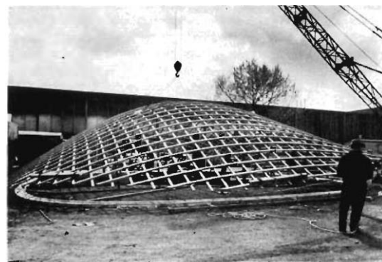
Figuur 3-8: Omhoog hijsen van de gridshell (bron: Frei Otto)
