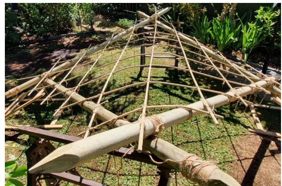
Figuur 6-72: Golfbeweging van de holle latten (kleur) en bolle latten (kleur)
