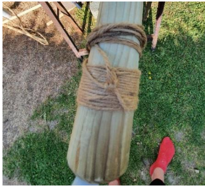
Figuur 6-66: Aanbrengen van trekkers
