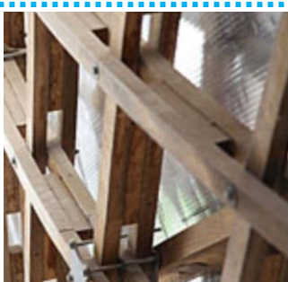
Figuur 3-43: Boutverbinding [19]
