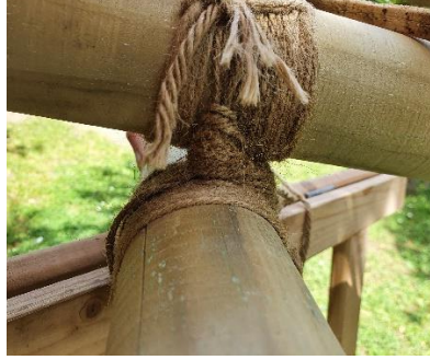
Figuur 6-62: Woelen van bolscharnier
