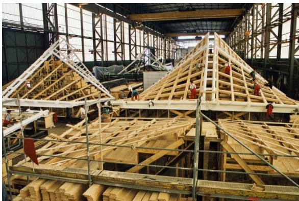
Figuur 7-7: Constructie schaaldaken (bron: Regie der Gebouwen)
