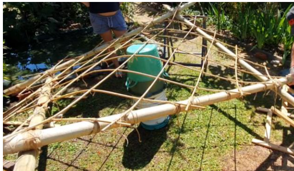
Figuur 6-75: Terugdraaien van de ringbalk leidt tot sterkere vervorming van het latwerk
