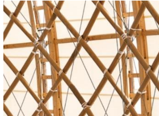
Figuur 6-25: Sjorverbinding Japan Pavilion (bron: Hiroyuki Hirai)
