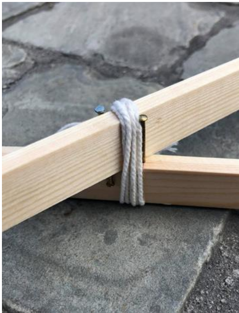
Figuur 8-26: Toevoeging van een eenvoudige sjoerverbinding
