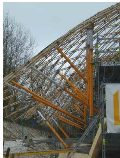
Figuur 3-54: Schoren aan de rand van het latwerk [19]
