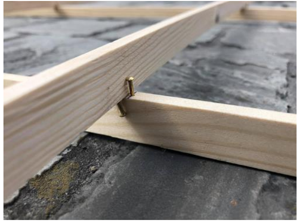
Figuur 8-25: Montage van het latwerk
