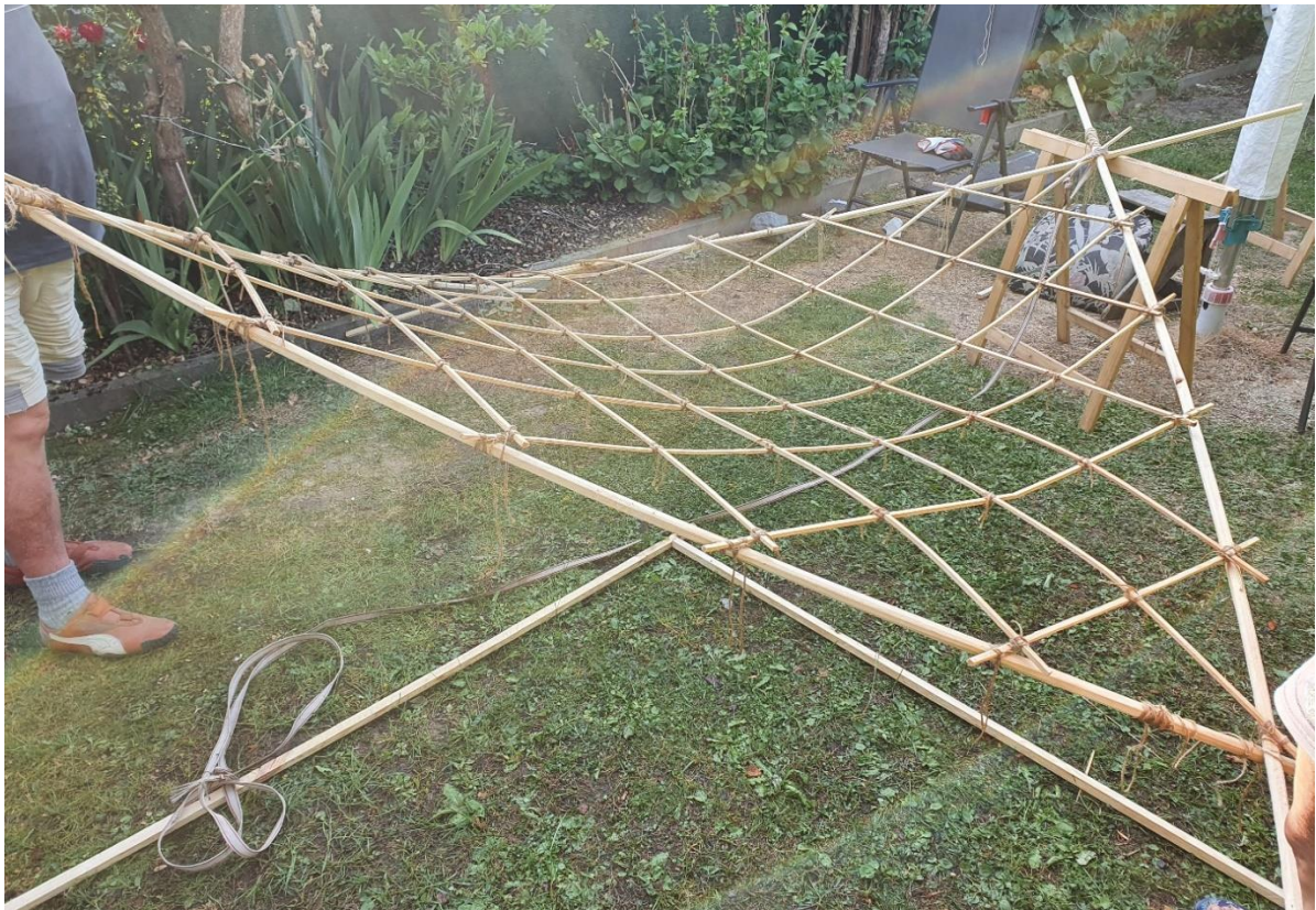
Figuur 6-57: Geknikte hyparschaal
