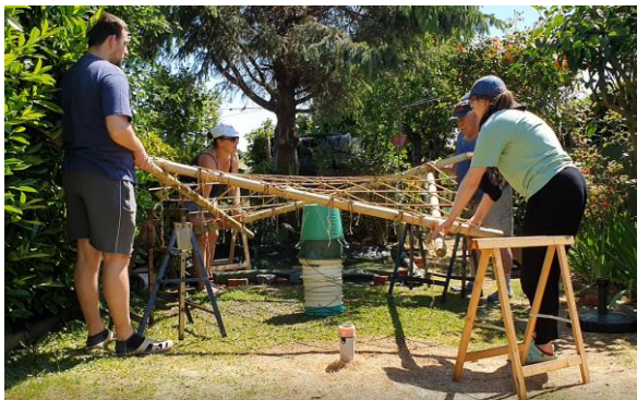
Figuur 6-69: Omhoogtrekken van de bovenste hoekpunten
