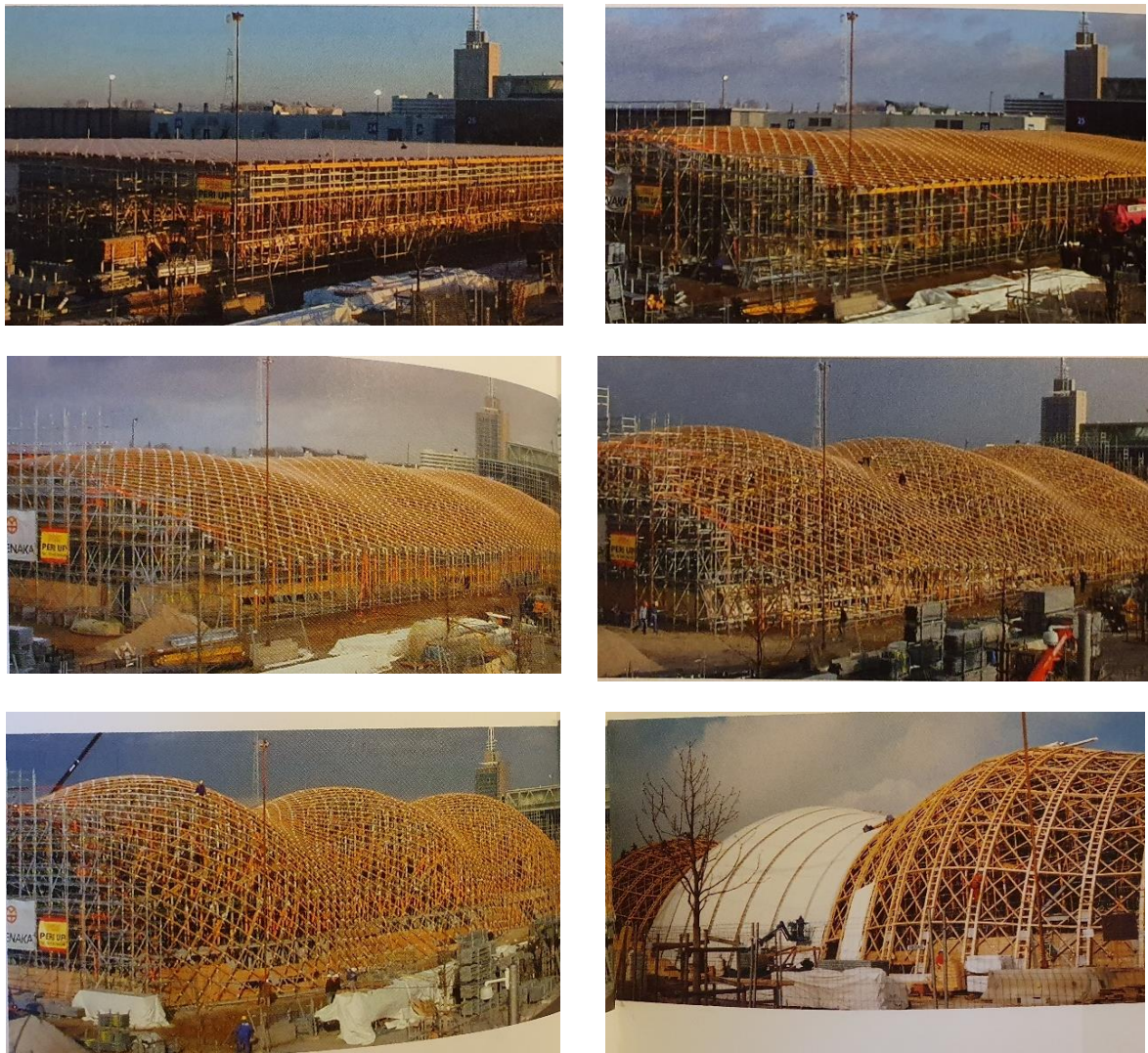
Figuur 3-36: Erectieproces Japan Pavilion [11]
