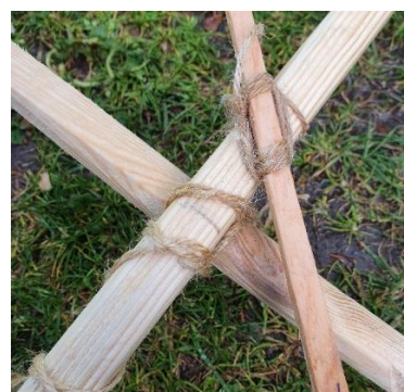
Figuur 6-56: Enkelvoudige sjorring van de ringbalk met rechts Japanse kruissjorring
