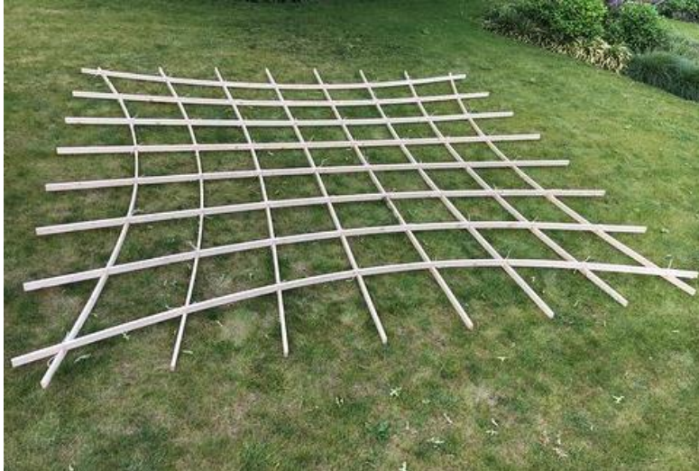
Figuur 8-34: Vlak latwerk voor het erectieproces
