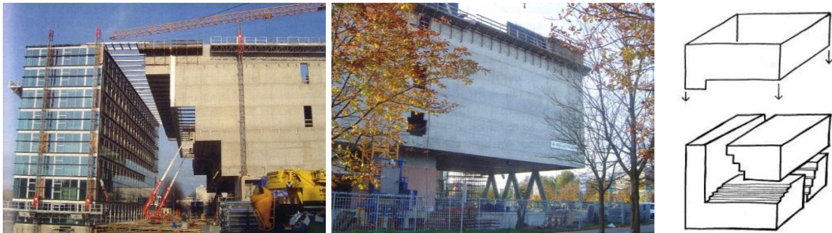
Afb. 5.28: Links: De volumes worden geconstrueerd alsof het aparte gebouwen zijn. Midden: Betongevel, hiertegen komt later de gekleurde glasgevel. Rechts: De glasgevel houdt de gebouwonderdelen samen. (© Neutelings Riedijk Architects. Uit [1])
