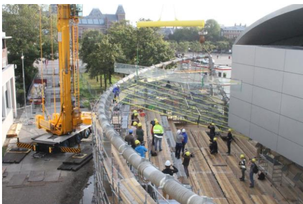
Afb. 4.14: De slanke dakliggers worden opgelegd in stalen schoen-elementen. (© Hajar Elouarrat)
