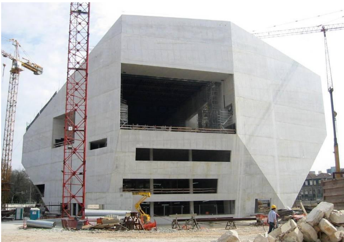
Afb. 2.4: Constructie van het Casa da Música in Porto. De grote opening wordt volledig van glas voorzien. (© Uit [2])
