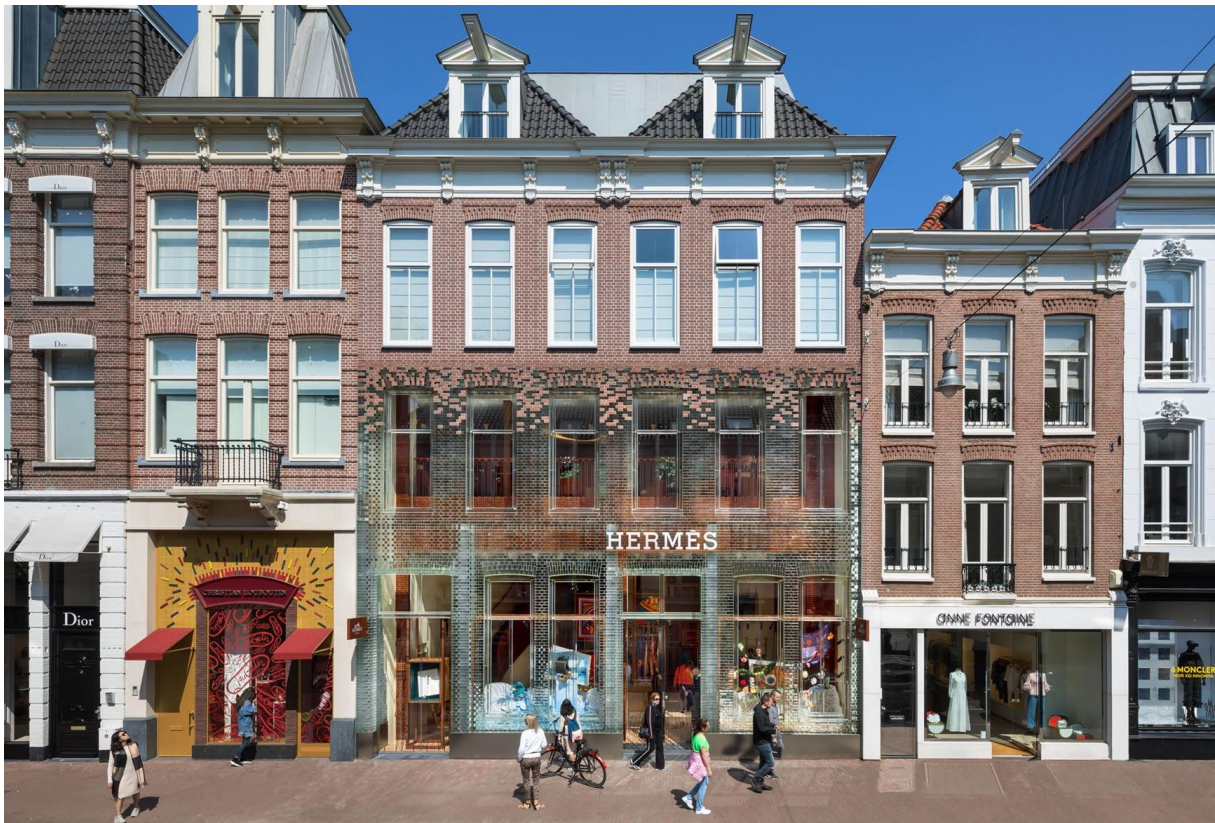
Afb. 1.1: Crystal Houses, een unieke winkelpui in Amsterdam ontworpen door MVRDV. (© MVRDV)
