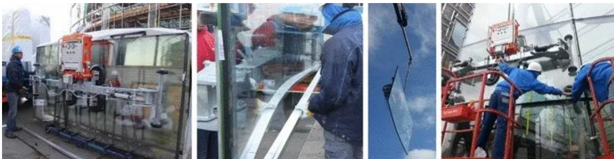
Afb. 4.18: Ter plaatse buigen, controleren, verplaatsen en installeren van koudgebogen glaseenheden. (© Octatube. Uit [1])
