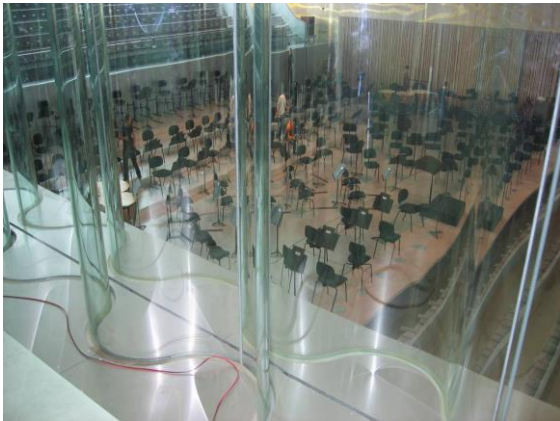
Afb. 2.6: De spouw tussen de twee gegolfde glazen wanden helpt de overdracht van geluid te reduceren. (© Uit [2])
