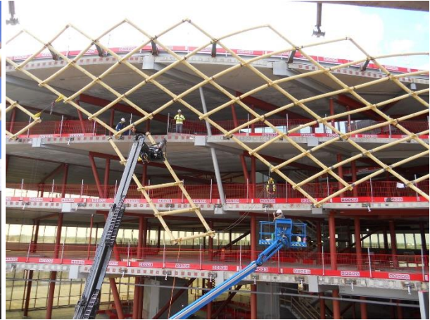
Afb. 3.5: Links: Bevestiging van de eerste stalen buisprofielen aan de bovenste betonnen vloerplaat. Rechts: Montage van het stalen grid. (© Folcrá)
