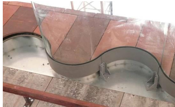
Afb. 2.8: De glaspanelen zijn bevestigd in stalen consoles. De stalen consoles zijn minder lang dan de glaspanelen, dit om problemen met de temperatuuroitzetting en het 'terugveereffect' van staal te minimaliseren. (© Jan Belis)
