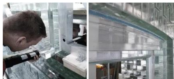
Afb. 1.14: Links: Het gelijktijdig aanbrengen van de acrylaatlijm aan beide kanten. Rechts: Het resultaat. (© Uit [1])
