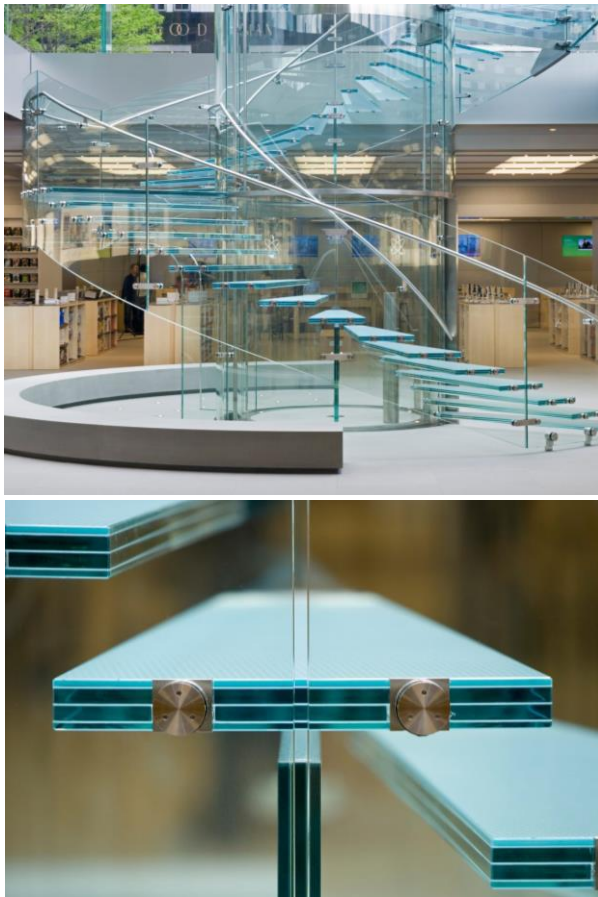
Afb. 6.17: Links: De volledig glazen (gepatenteerde) wenteltrap die gebruikt werd bij de twee eerste versies van de winkel (2006 en 2011). (© Peter Aaron). Rechts: De nieuwe wenteltrap met stalen treden en weerspiegelende liftkoker, naar het ontwerp van Foster+Partners. (© Aaron Hargreaves)
