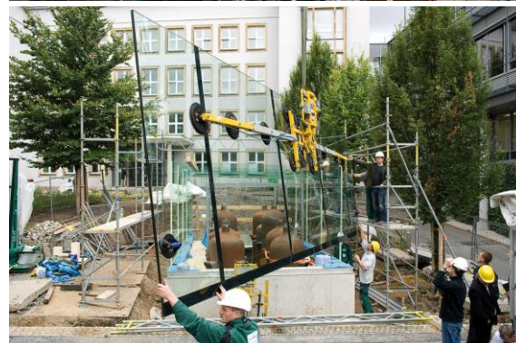
Afb. 6.27: Boven: Montage van de glazen portieken. Onder: Installatie van de grote zijpanelen. (© uit [1])
