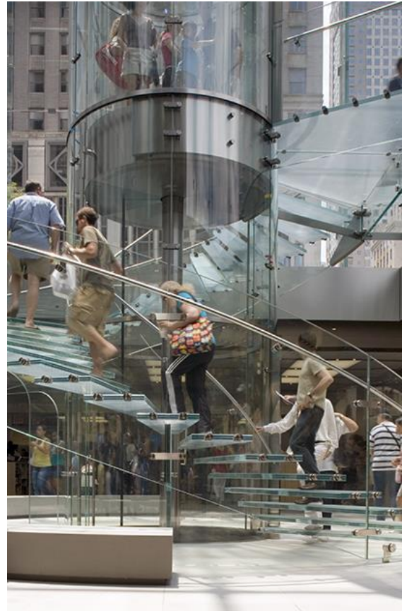
Afb. 6.3: De glazen leuning en de glazen liftschacht nemen de belastingen op de trap op. (© architizer.com)
