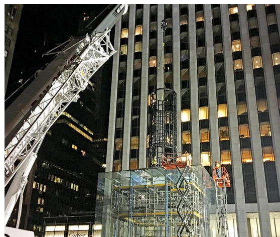
Afb. 6.16: Installatie van de trapkoker. (© Uit [10])
