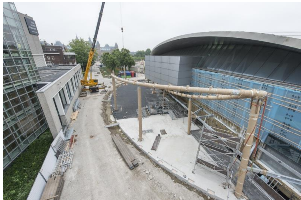
Afb. 4.12: Opbouw van de structuur uit ronde holle staalprofielen. (© Jan Kees Steenman)
