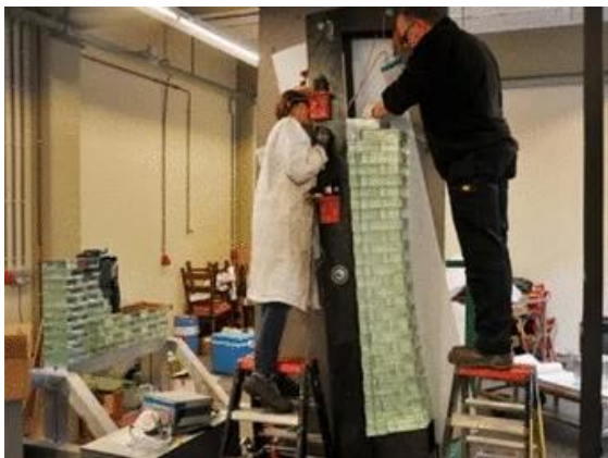
Afb. 1.10: De roterende bevestiging bij de voormontage van de lateien. (© Uit [1])
