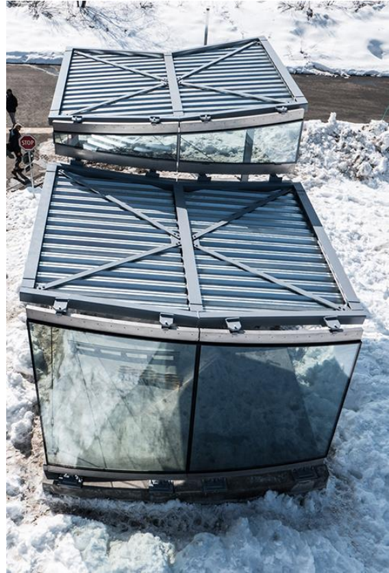
Afb. 6.40: Model op ware grootte. Elke IGU heeft twee steunpunten onderaan en twee bevestigingspunten met de dakconstructie bovenaan. De belasting van het dak wordt via druk doorheen het glaspaneel doorgegeven aan de steunpunten. (© CCHE Lausanne SA)
