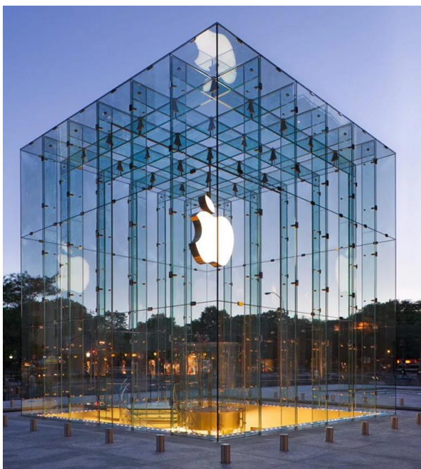
Afb. 6.10: Na vijf jaar werd de glazen kubus al gerenoveerd. Het volume bleef hetzelfde, maar het aantal glaselementen daalde drastisch. Links: De 'Apple Cube' uit 2006. (© en.wikiarquitectura.com). Rechts: De 'Apple Cube' uit 2011. (© Peter Aaron)
