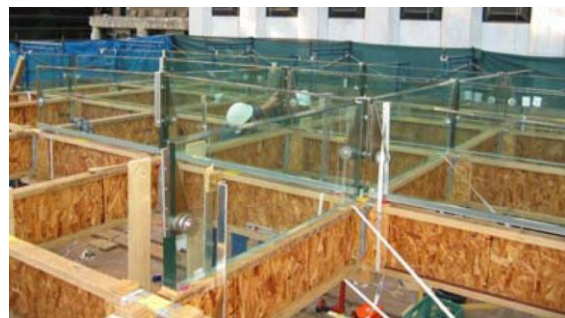
Afb. 6.9: Constructie van het dak. (© uit [1])
