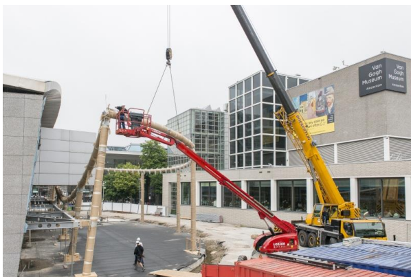
Afb. 4.13: Links: Staalstructuur is compleet. Rechts: Het plaatsen van de glazen dakliggers kan beginnen. (© Jan Kees Steenman)
