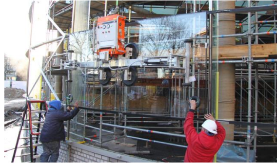
Afb. 4.23: De gemodificeerde zuigmachine CladBoy CB5 die gebruikt werd bij de installatie van de gevelpanelen van het Van Gogh museum in Amsterdam. (© BRS Building Systems)
