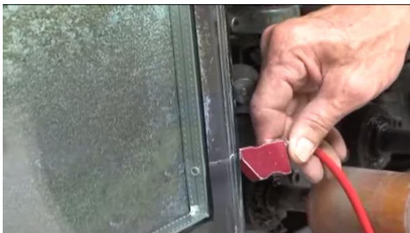
Afb. 5.14: Links: De IGU wordt handmatig gevuld met argongas. Rechts: Aanbrengen van structurele Siltal-voeg. (© AGC Westland, VIDEO: AGC - De Glazen Boerderij (Glass Farm) - Artlite Digital)
