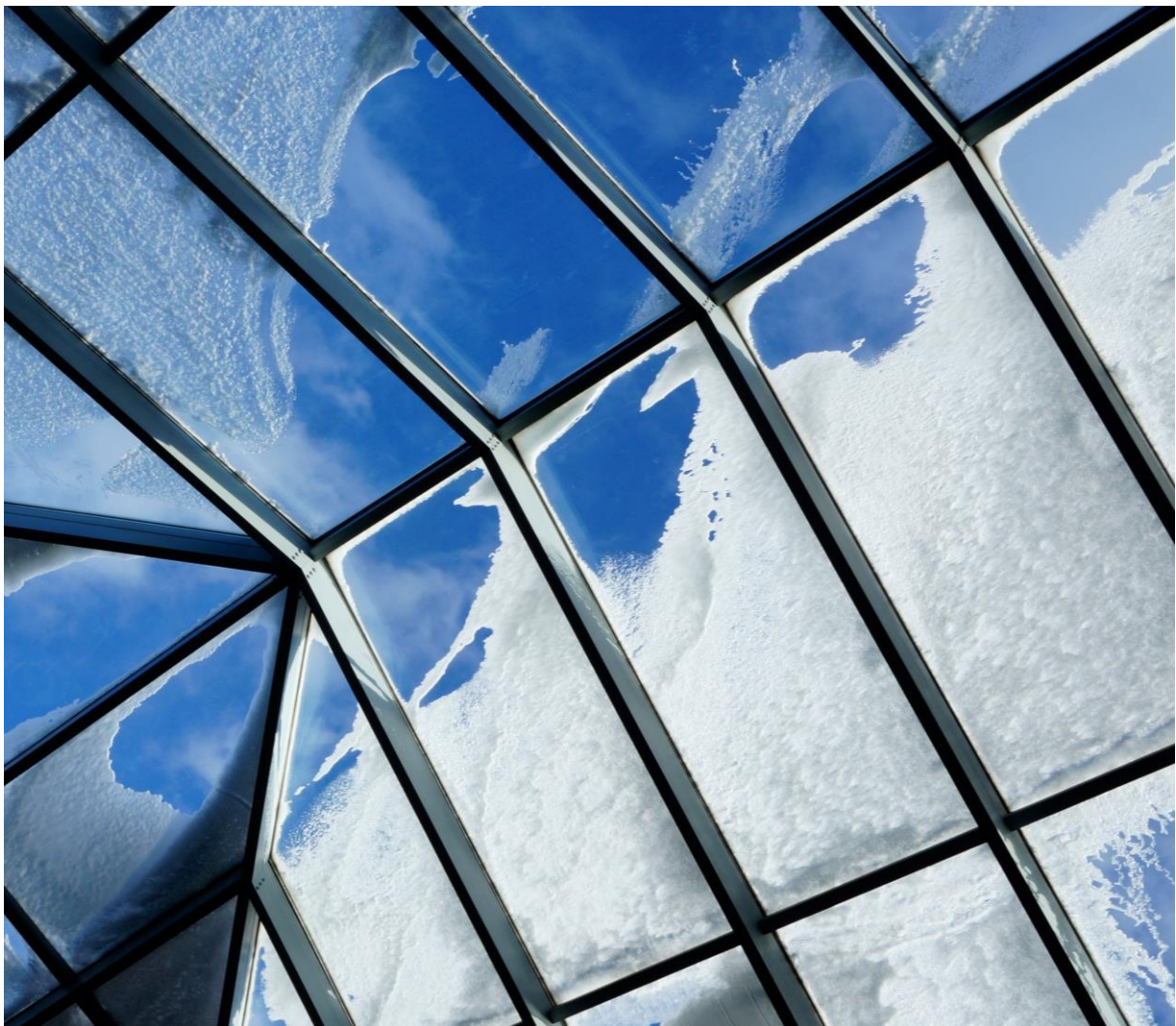
Afb. 5.3: Het opgewarmd glas helpt om de sneeuw te laten smelten. (© New Glass Tech. Thermo Heat Glas)
