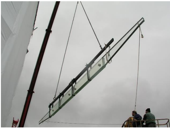
Afb. 1.29: De installatie van de glazen liggers. De bovenloopkraan en het dak van de tent werden voorafgaand gedemonteerd om de plaatsing mogelijk te maken. (© Bellapart)
