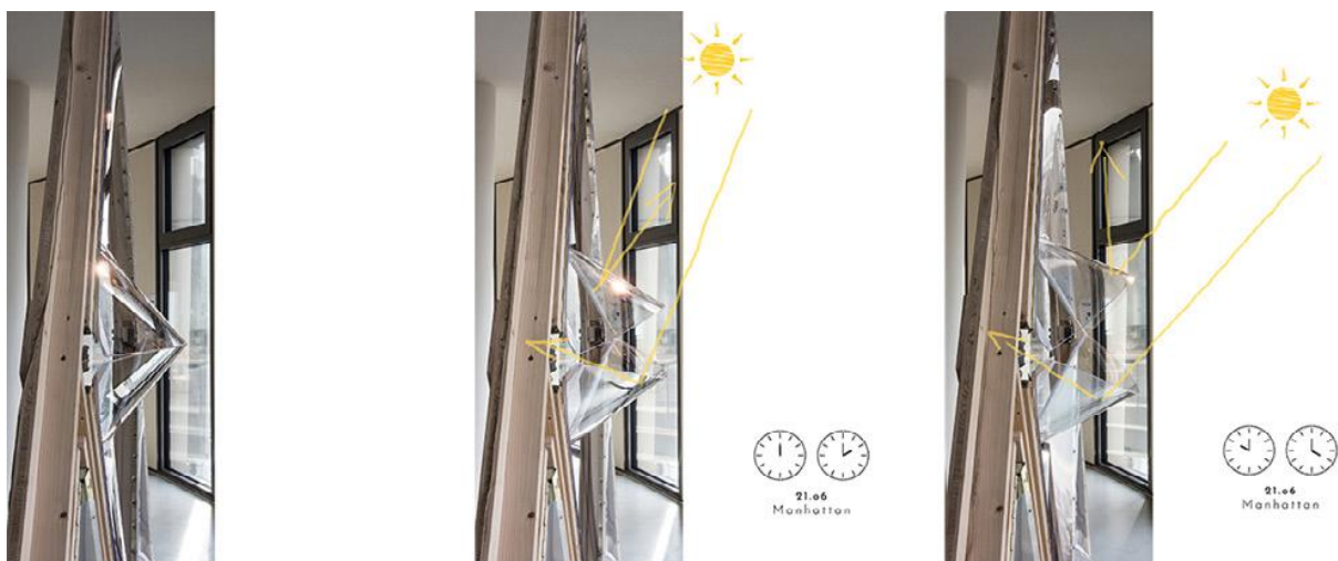
Afb. 7.4: Diverse zonnestanden en bijbehorende openingshoeken van het dun glas. (© JRC)
