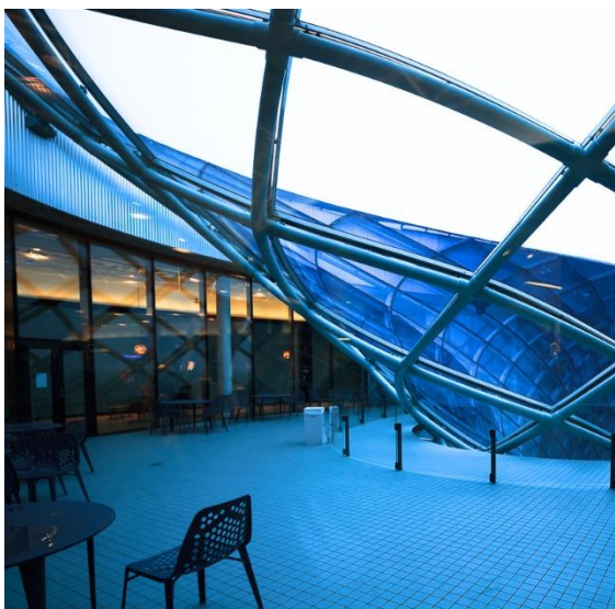
Afb. 3.9: De organische glasgevel creëert patio-achtige ruimtes in de tussenzone. (© John Johanson)
