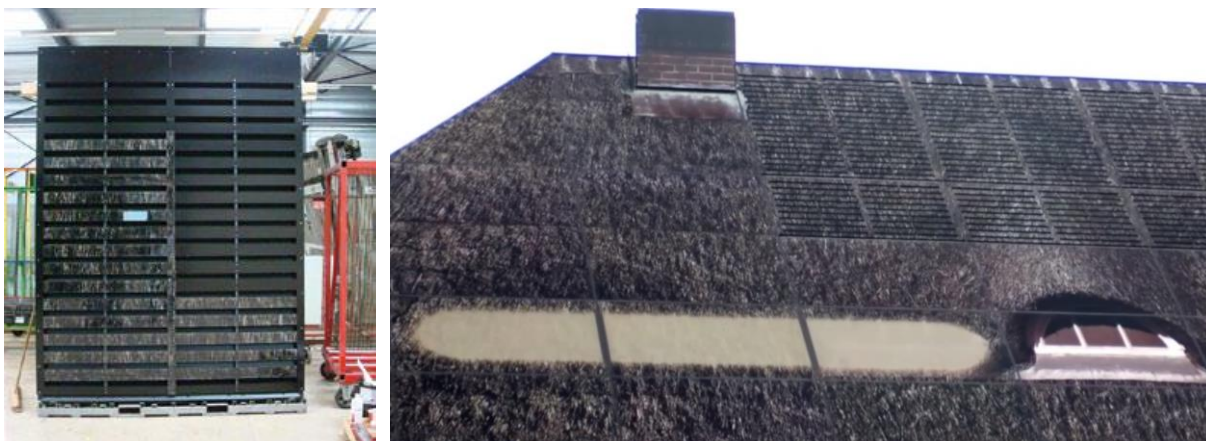
Afb. 5.3: Links: Verlijming van bedrukt glas op een dakrooster (© [3]). Rechts: De roosters zijn mooi geïmplementeerd in het dakvlak dankzij de doorlopende print. (© VIDEO: AGC - De Glazen Boerderij (Glass Farm) - Artlite Digital)
