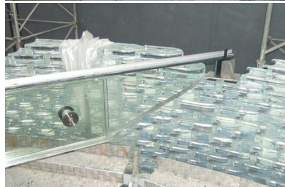
Afb. 1.28: Boven: Assemblage van de glazen liggers. Onder: Oplegging van een dakligger. (© Bellapart)
