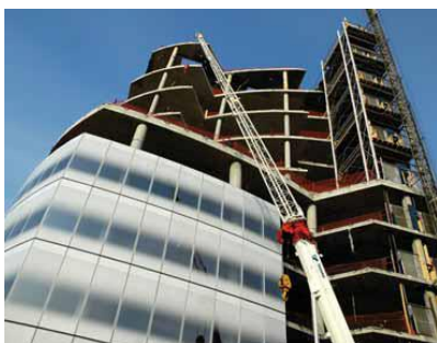
Afb. 4.5: De gevelelementen werden in situ gebogen. Ze werden gefixeerd zodra ze de gewenste vorm hadden bereikt. (© Steel Institute of New York. Uit [1])
