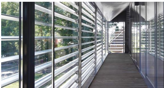
Afb. 2.1: Vaste 'structurele' zonwering worden boven of voor glaspartijen geplaatst. (© solyscreen.nl)
