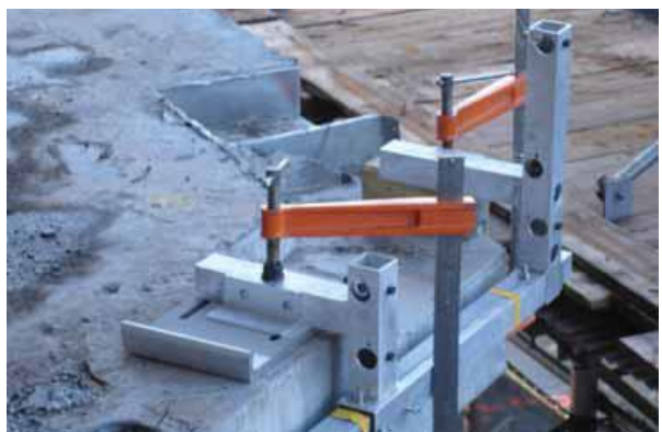
Afb. 4.4: X-, Y- en Z-coördinaten werden uit het model gehaald om de beugels precies te kunnen installeren. (© Steel Institute of New York. Uit [1])
