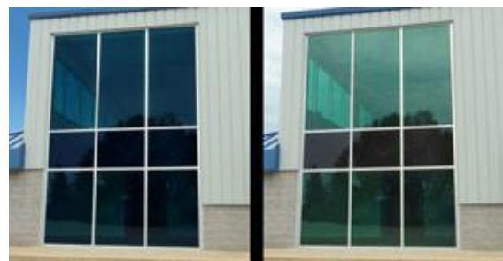
Afb. 2.2: Thermochromisch glas verdonkert automatisch naarmate de warmtebelasting toeneemt (links). Het raam keert terug naar een meer heldere staat naarmate het zonlicht afneemt (rechts). (© Pleotint®, PPG Industries)
