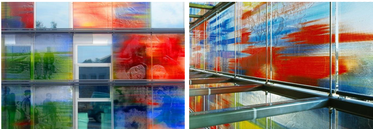
Afb. 5.29: Links: De gekleurde glasgevel tegen een gebouwonderdeel met achterliggend schrijnwerk. Rechts: De gekleurde glasgevel ten hoogte van de centrale hal. (© drupsteen.nl)
