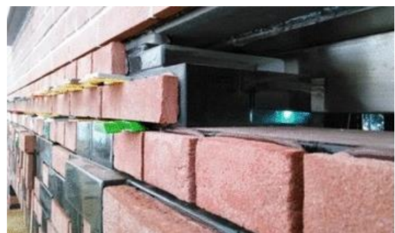
Afb. 1.12: De aansluiting tussen het glasmetselwerk en de stalen ligger zit verborgen. (© Uit [1])
