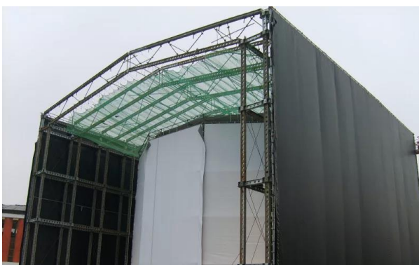
Afb. 1.25: Links: De beschermde tent tijdens het bouwen. (© [5]) Rechts: De glazen ellips wordt rij per rij opgebouwd. (© [3])
