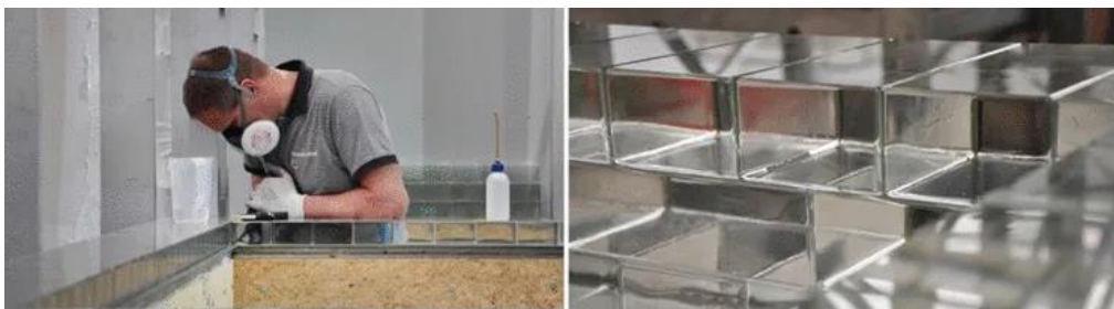
Afb. 1.9: Afdichting van de reeds verlijmde stenen. (© Uit [1])
