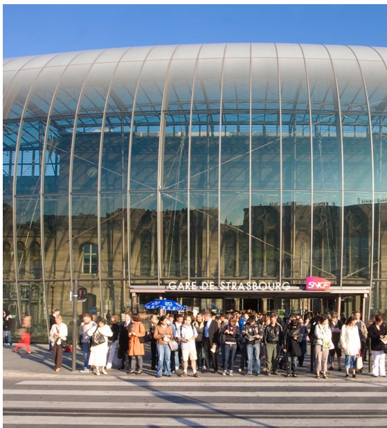
Afb. 4.32: Het stationsgebouw in Straatsburg maakte gebruik van de koude laminaatbuigingstechniek. Zo werd het gewenste effen en uniforme uitzicht bereikt, terwijl ook energie en kosten werden verlaagd. (© Sedak)
