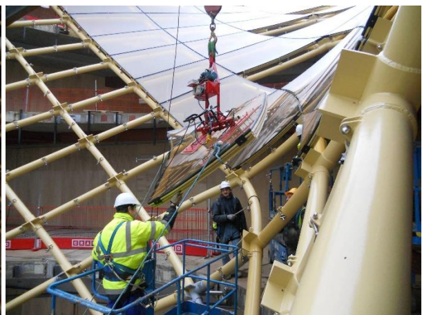
Afb. 3.7: Elk glaspaneel is door middel van acht steunpunten aan de staalconstructie bevestigd. (© Folcrá)
