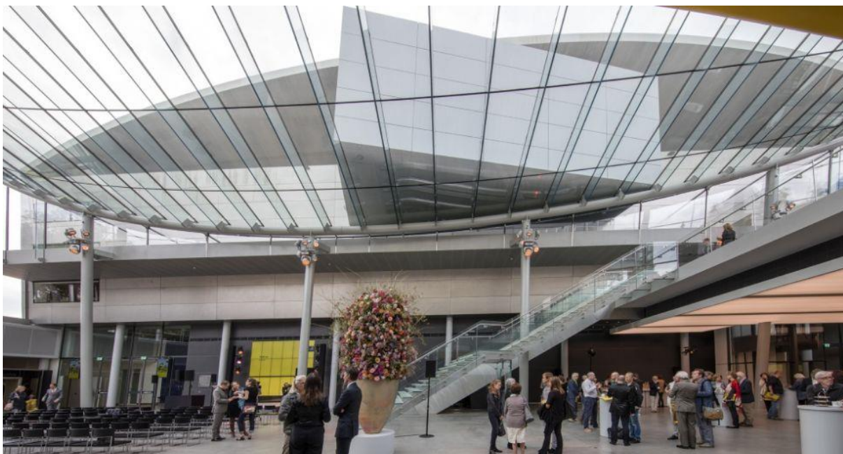
Afb. 4.19: Het transparante dak wordt ondersteund door glazen liggers. (© Michael van Oosten)
