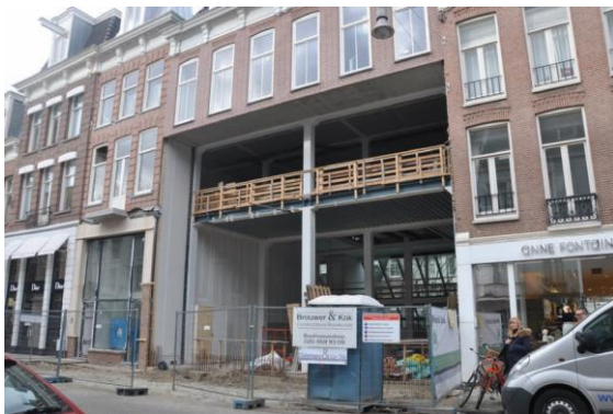
Afb. 1.3: De traditionele metselwerkmuur werd voorafgaand gebouwd. (© Uit [2])
