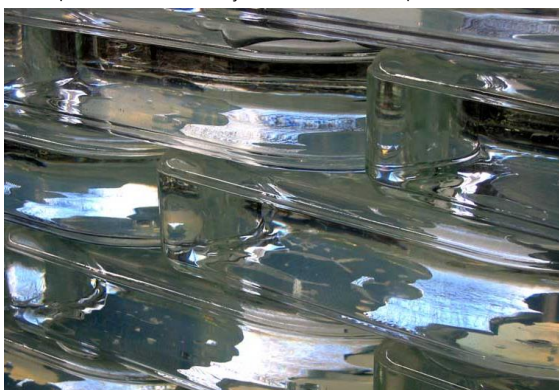
Afb. 1.27: Close-up van de transparant gebonden glasstenen. (© Uit [4])
