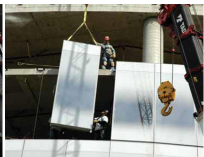
Afb. 4.5: De gevelelementen werden in situ gebogen. Ze werden gefixeerd zodra ze de gewenste vorm hadden bereikt. (© Steel Institute of New York. Uit [1])
