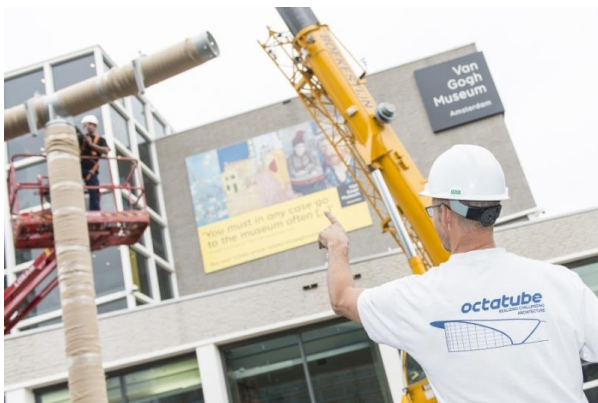
Afb. 4.12: Opbouw van de structuur uit ronde holle staalprofielen. (© Jan Kees Steenman)
