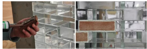
Afb. 1.11: Links: Het aanbrengen van de strips. Rechts: Het resultaat na de afdichting. (© Uit [1])
