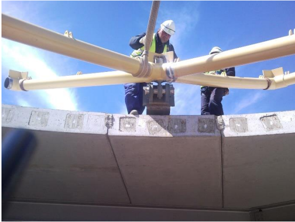
Afb. 3.5: Links: Bevestiging van de eerste stalen buisprofielen aan de bovenste betonnen vloerplaat. Rechts: Montage van het stalen grid. (© Folcrá)
