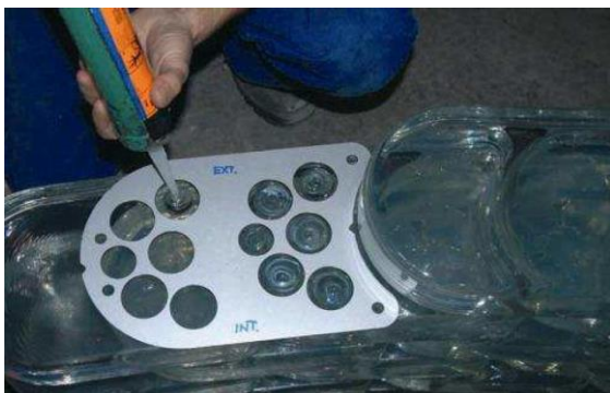
Afb. 1.26: Verdeling van de lijm op de glasblokken met behulp van aluminium sjablonen. (© Bellapart)
