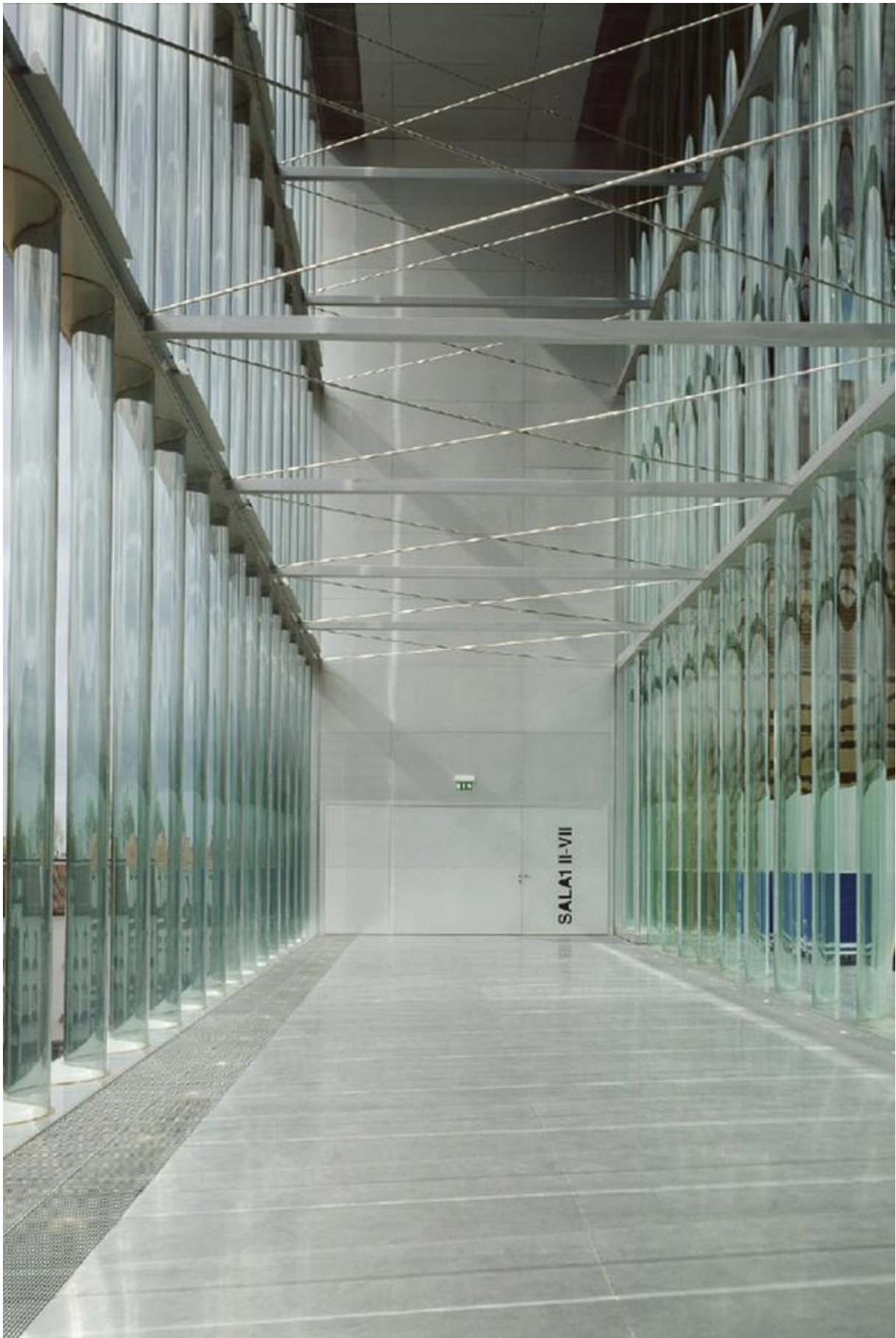
Afb. 2.5: Horizontale stalen spanten ondersteunen de gegolfde glaspanelen. (© Philippe Ruault)
