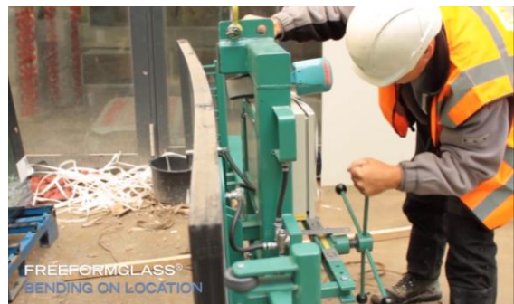
Afb. 4.24: Freeformglass®-panelen worden op de bouwplaats gekromd. (© BRS Building Systems)
