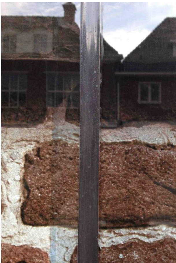
Afb. 5.10: De 20mm brede afdichtingsvoeg. (© MVRDV)
