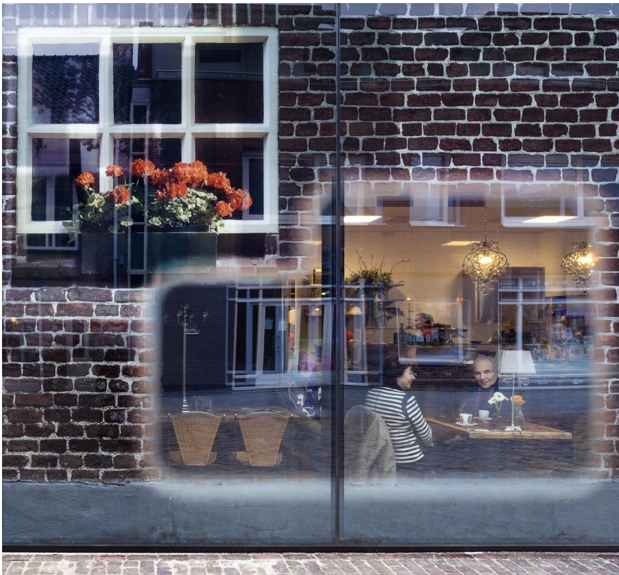
Afb. 5.7: Een geprint traditioneel raam met bloembak versus een transparant gelaten deel in de print. (© MVRDV)
