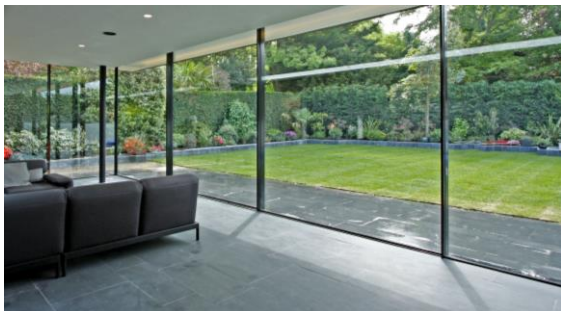
Afb. 5.4: Dankzij het gebruik van verwarmd glas moeten er geen hinderlijke verwarmingselementen voor het glas geplaatst worden. (© New Glass Tech. Thermo Heat Glas)
