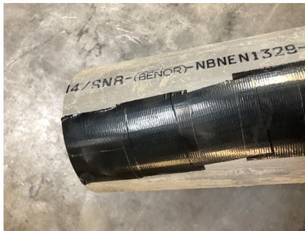
Figuur 14: Afplakken van de axiale naad
