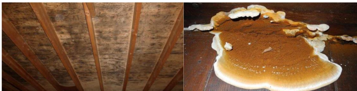
Figuur 5 a) Houtverkleuring veroorzaakt door oppervlakteschimmels b) Bruinrotschimmel op hout ( Serpula lacrymans ) (Vanpachtenbeke et al., 2016)
