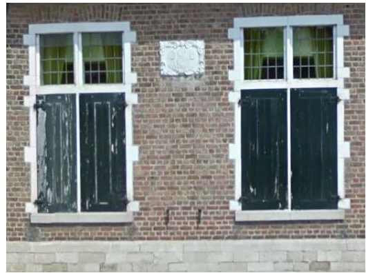
Afbeelding 27: Kruisramen met dubbele ontlastingsboog in de hoeve in Grimbergen van Minner, foto, 2018, Grimbergen, Agentschap Onroerend Erfgoed.
