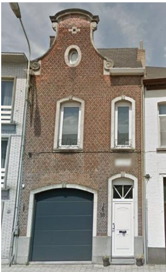
Afbeelding 43: Huis in Liersesteenweg in Kessel (Nijlen), wederopgebouwd met hulp van de OSB ca. 1920, foto, 2017, Google.
