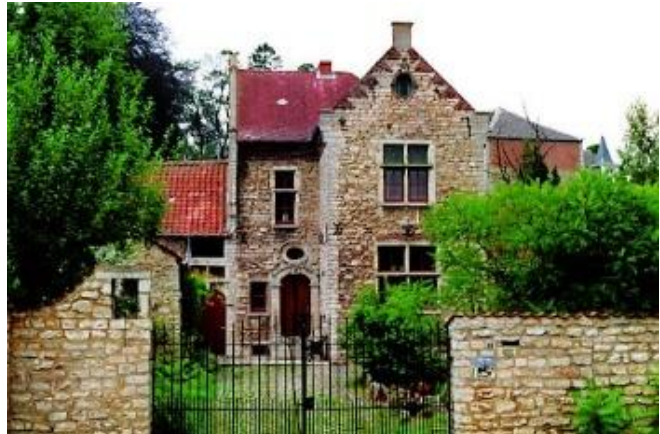
Afbeelding 25: Dubbelwoning in Rue de Rivage in Jodoigne (Gobertange) in 'Gobertangestein', foto.
