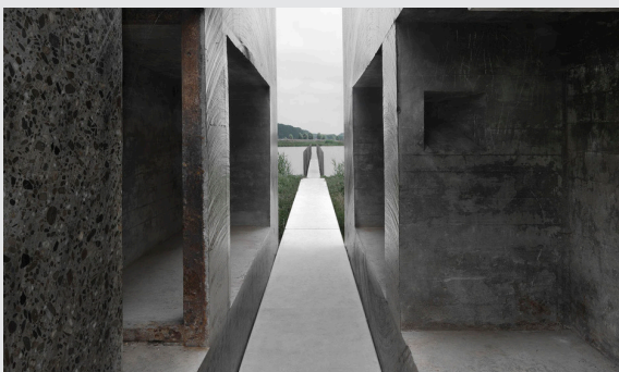
Figuur 5: Opgesneden Bunker 599. Foto door RAAF en Atelier de Lyon.
