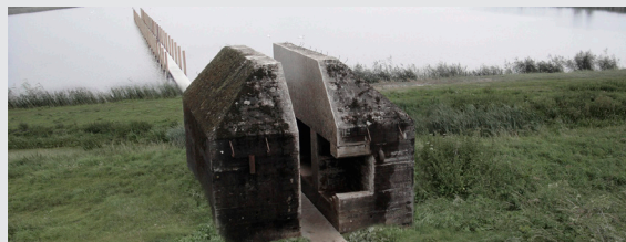
Figuur 15: Bunker 599 en het overstromd gebied. Foto door Bart Van Hoek.
