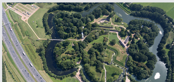
Figuur 16: Fort Vechten. Foto door Ossip Van Duivenbode.
