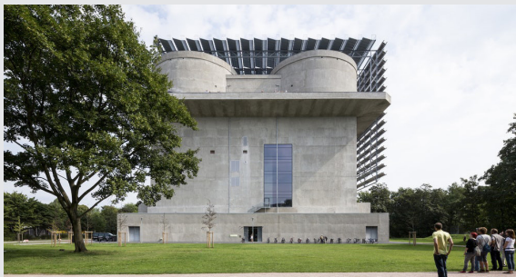
Figuur 13: FLAK toren VI in Wilhelmsburg. Foto van IBA Hamburg
