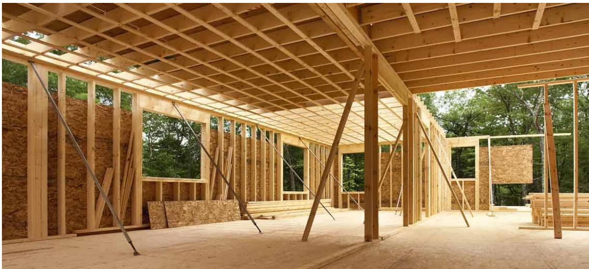
Figuur 1: Houtskeletbouw in constructiefase (Offrea, 2019)
