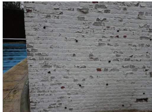
Fig. 19 :Links schimmelvorming zuidwestgevel, rechts afbladdering van de waterwerende oppervlaktebehandeling
