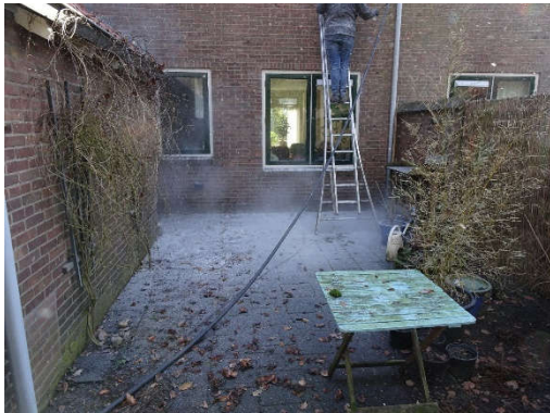
Fig. 18: Stof en kleine stukjes van UF-schuim die de lucht indwarrelden
