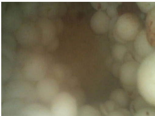
Fig. 20: EPS-parels die aan het binnen- en Buitenspouwblad kleven
