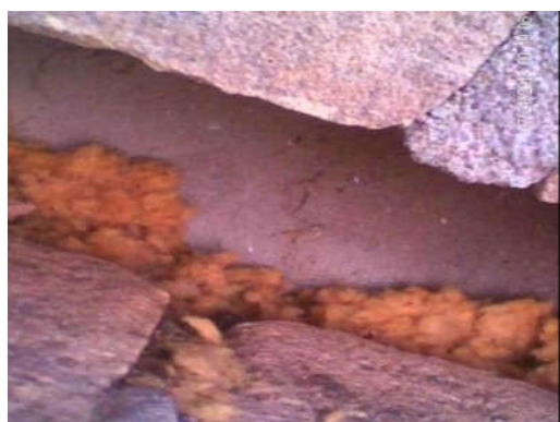
Fig. 23: Isolatie onder het extractiepunt
