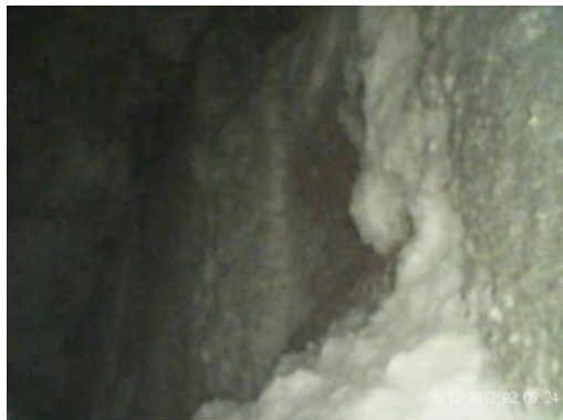
Fig. 22: Spouwmuurisolatie vrij boven het extractiepunt enkel nog mortelbarden
