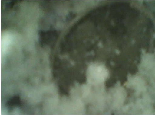
Fig. 17: Verpulverd UF-schuim in de spouw
