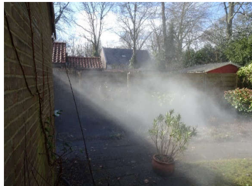
Fig. 18: Stof en kleine stukjes van UF-schuim die de lucht indwarrelden
