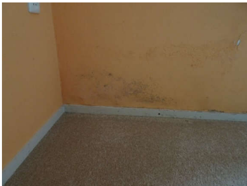
Fig. 19 :Links schimmelvorming zuidwestgevel, rechts afbladdering van de waterwerende oppervlaktebehandeling
