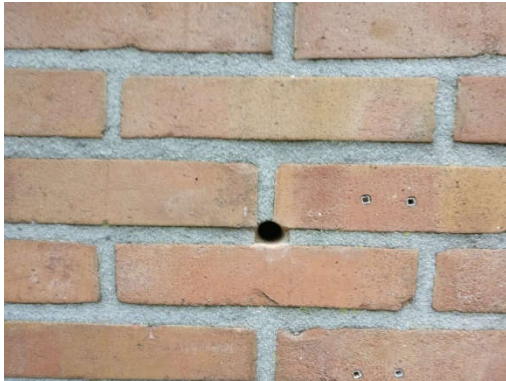
Fig. 4: Inblaaspunt in kruising lint- en stootvoeg
