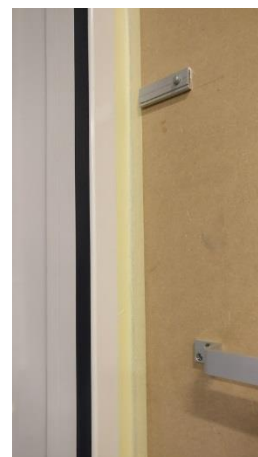
Figuur 26: Luchtdicht gemaakte deuropening
