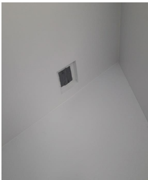
Figuur 71: afdichting ventilatie W4
