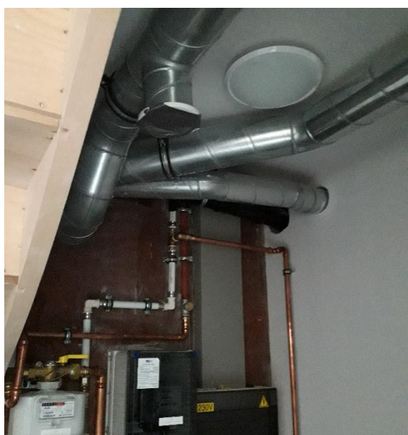
Figuur 61: afdichting ventilatie W3
