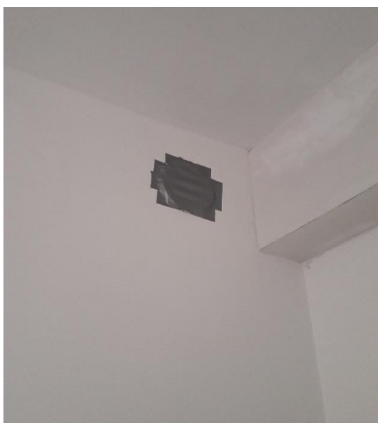
Figuur 90: afdichting ventilatie W8
