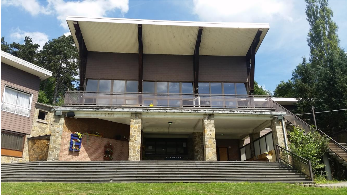
Afb. 70: Het paviljoen in gebruik als eetzaal, de structuur is intact maar het aantal ramen verminderd. Foto: Eveline De Wilde, 2017.
