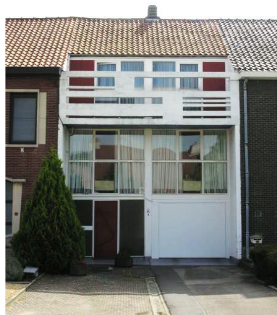
Afb. 56: Willy Van Der Meeren, woning De Leeuw , 1959 -1960, Mechelen. Bron: https://inventaris.onroerenderfgoed.be/erfgoedobjecten/1482 . Foto: Timo Van Havere, 2011.
