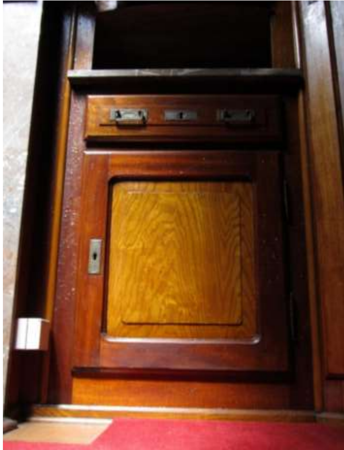
Afb. 45 Werken met de contrasten eigen aan het hout: een grenen paneel in een encadrement van acajou in het achteronder van de 'Lauranda' (Baasrode, 1928).
