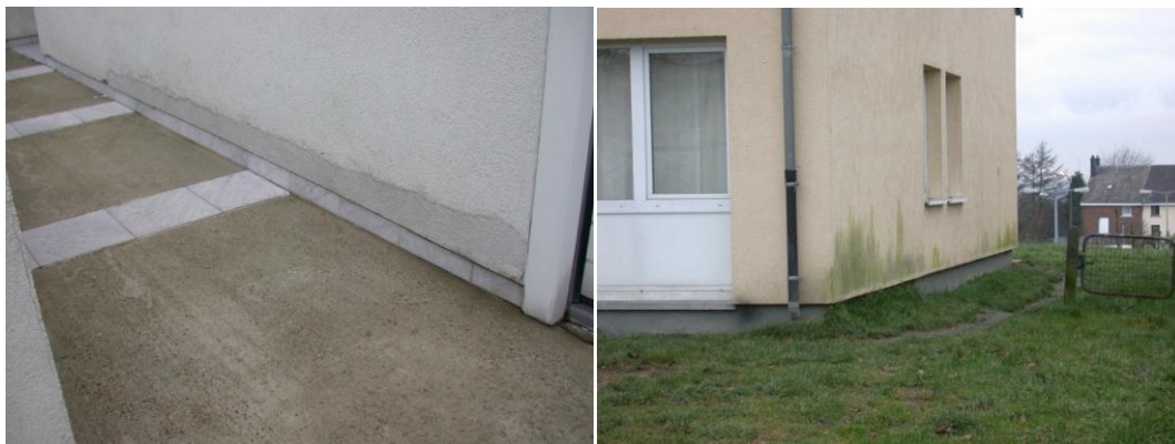
Figuur 15: Risico's bij een foutief uitgevoerde muurvoet
