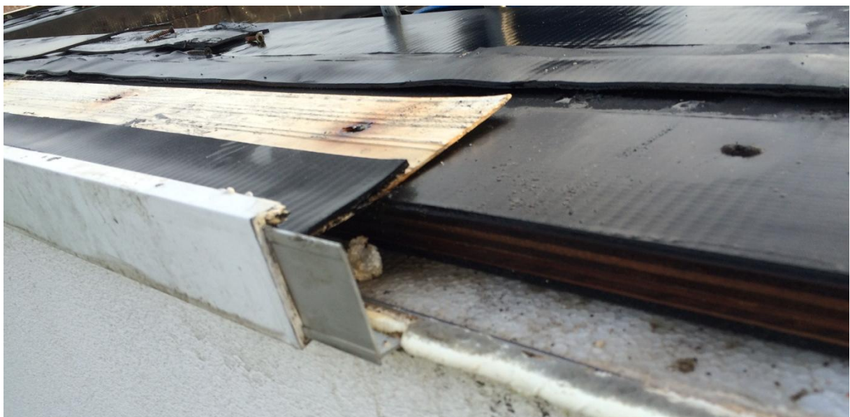
Figuur 161: Het openleggen van de dakrand
