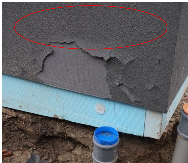
Figuur 156: Hoek aan de westgevel
