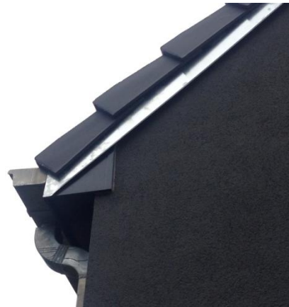
Figuur 155: Afgewerkte dakrand
