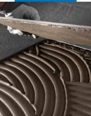
Plaatsen van dunne porcelain tegel op vloer
