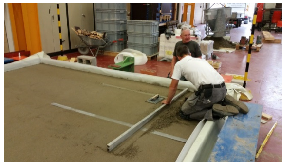
Figuur 20: Nivelleren van de dekvloer
