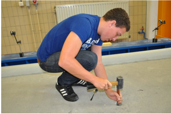
Figuur 57: Wegname proefstaal uit dekvloer
