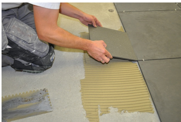
Figuur 21: Plaatsing vloertegel 30 cm x30 cm
