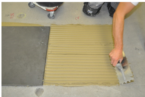
Figuur 23: Aanbrengen cementlijm op dekvloer
