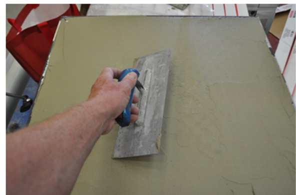
Figuur 24: Aanbrengen cementlijm op tegelrug
