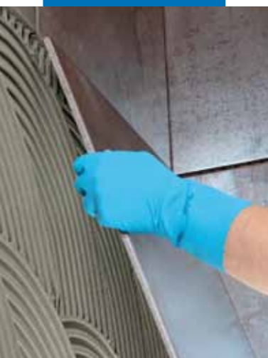
Aanbrengen van grote keramische tegels op de wand
