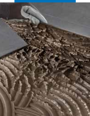
Controleren van de volledige back-buttering methode op dunne porcelain gres tegel
