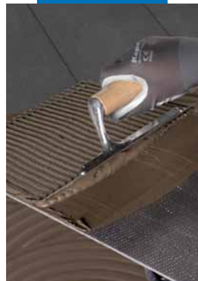
Het aanbrengen van de lijm op de achterkant van de tegel
