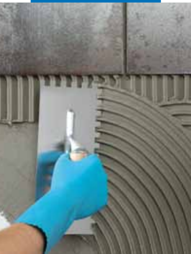
Aanbrengen van Ultralite S1 met een getande lijmkam
