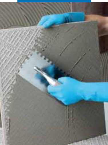
De lijm op de rug aanbrengen
