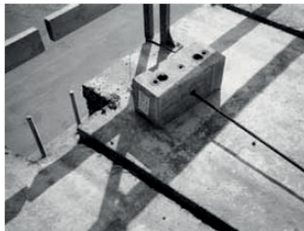
1 | LEVO-blokje; de kanaalplaten zijn van uitsparingen voorzien
