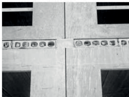
2 | LEVO-blokje tussen wandelementen en kanaalplaten
