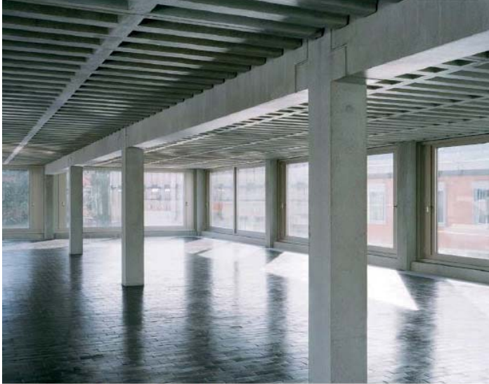
EW Buchs, Innenraumcharakter aus der primären Rohbaustuktur
