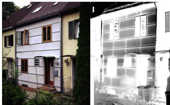
Figuur 19: Detail aansluiting en infrarood thermografie die de koudebruggen toont. [46]
