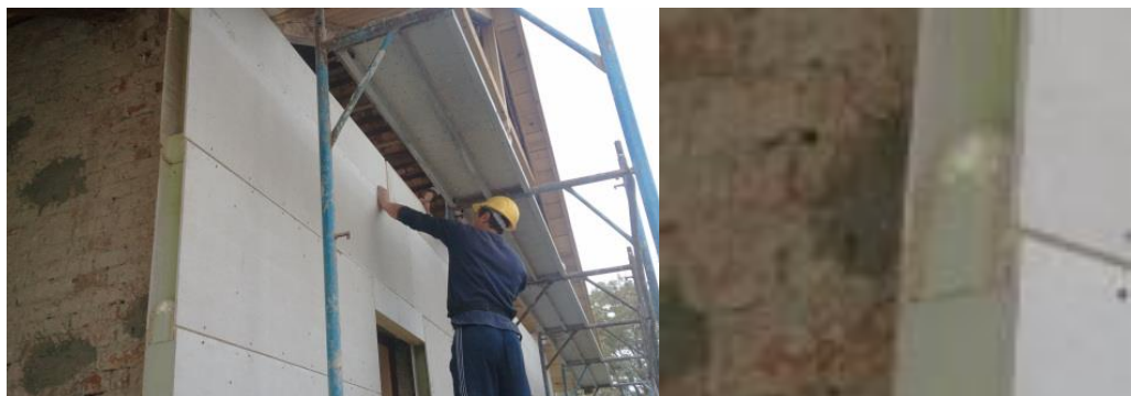
Figuur 32: Installatie van de SIP's.
