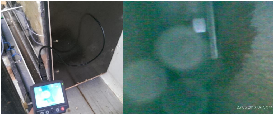
Figuur 108: Controle van waterdichtheid aan binnenzijde van het buitenpaneel; links: camera doorheen opening in zijkant luchtdichte kast; rechts: beeld van camera aan binnenzijde buitenpaneel ter hoogte van de bevestiging.
