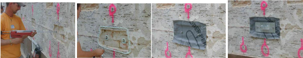
Figuur 22: Afdichting van de wandbevestigingsconsole om de luchtdichtheid te verbeteren. [38]
