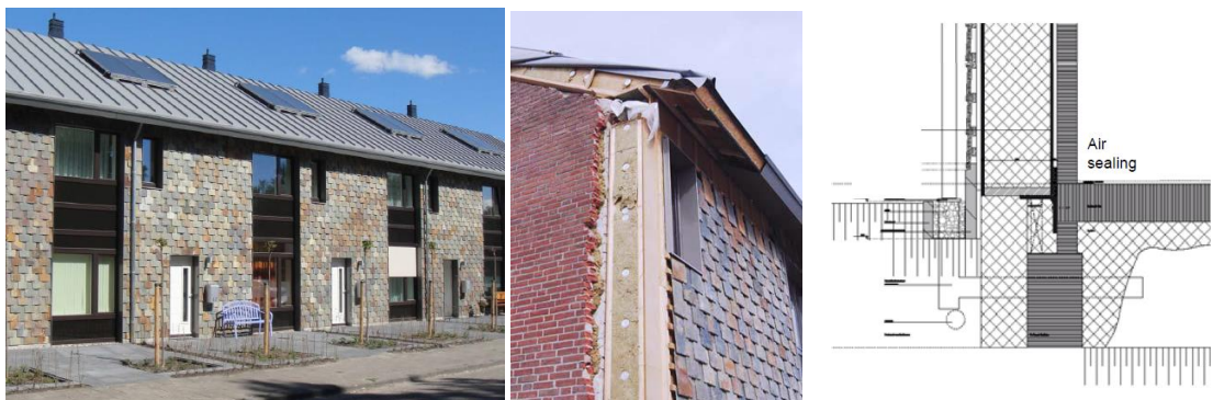
Figuur 36: Gevelrenovatie in Roosendaal. [21]
