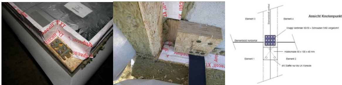
Figuur 35: Bevestigingsmethode van het paneel. [33]
