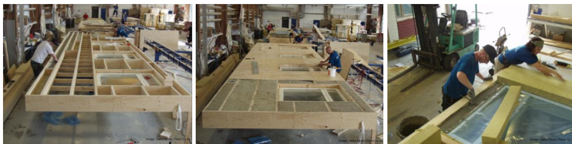
Figuur 27: Prefabricatie van het TES element. [31].
