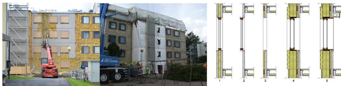
Figuur 29: Voorbereiding en montage van de elementen aan de bestaande gevel. [31].
