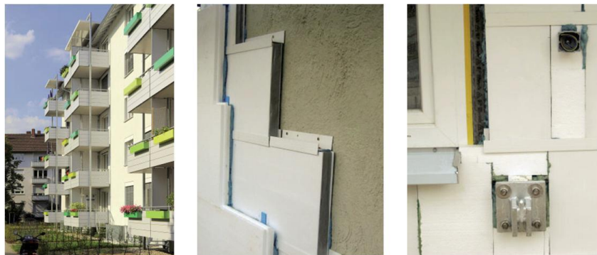
Figuur 20: Gevelisolatie in Karlsruhe.[26]
