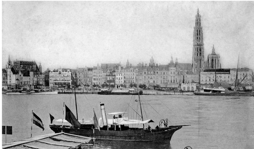
Figuur 18: de rede van Antwerpen gezien vanop de linkeroever (1911), met vooraan de Sint-Annekesboot, de stoomveer die pendelaars richting stad
