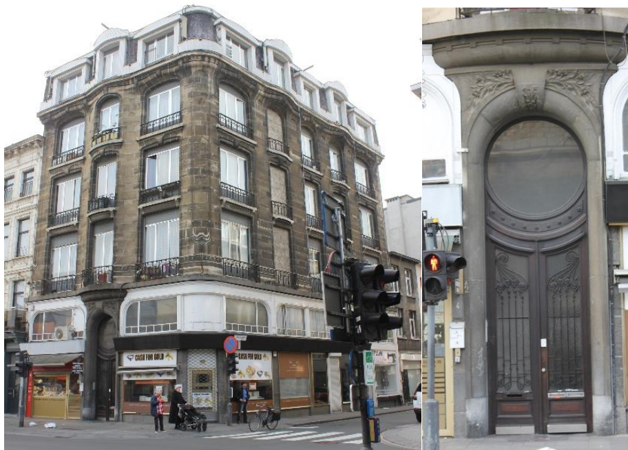
FIGUUR 3 HUIDIGE SITUATIE SIMONSSTRAAT 2-4, EIGEN FOTO
