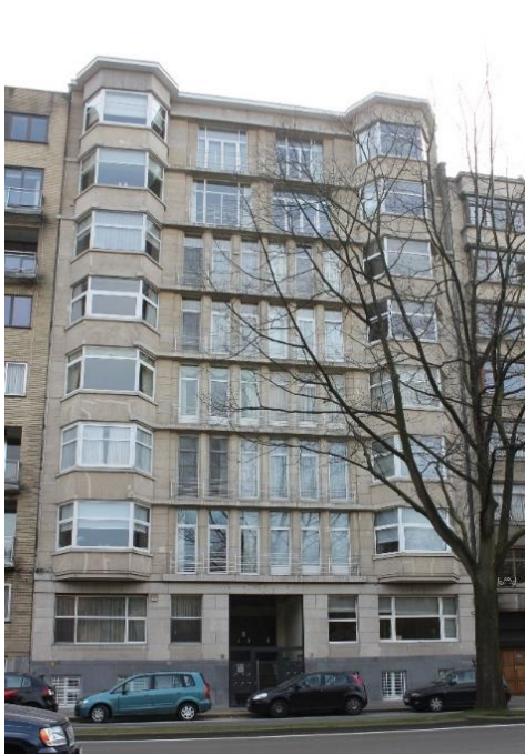
FIGUUR 77 HUIDIGE SITUATIE, EIGEN FOTO
