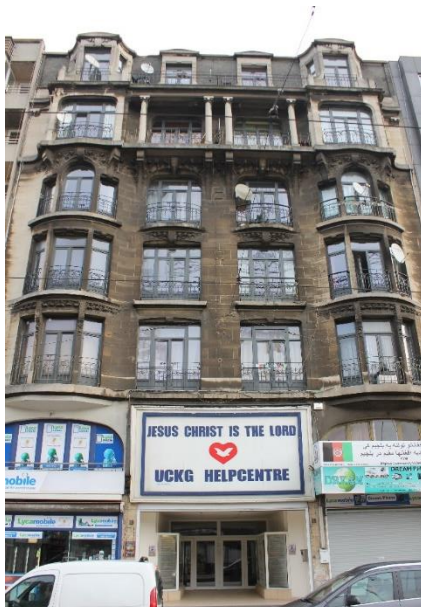
FIGUUR 9 HUIDIGE SITUATIE, EIGEN FOTO
