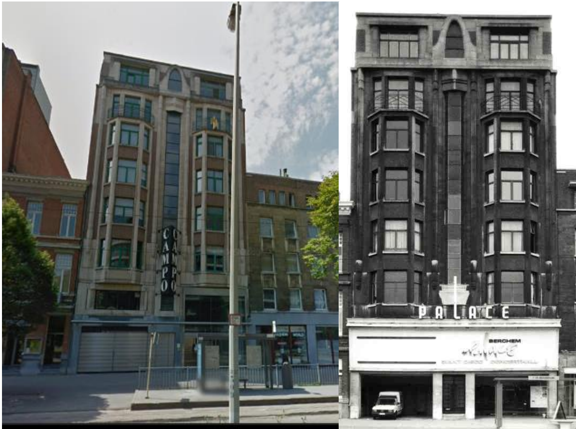
FIGUUR 63 HUIDIGE SITUATIE GEVEL 44
