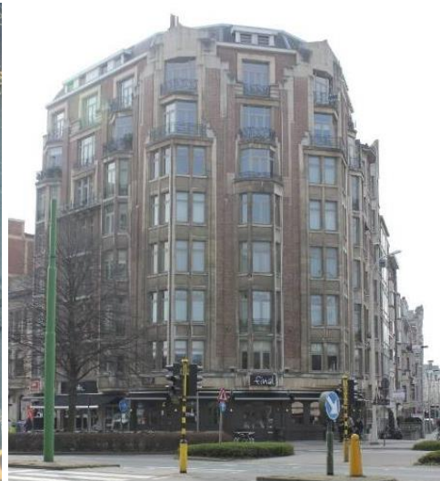
FIGUUR 54 HUIDIGE SITUATIE, EIGEN FOTO
