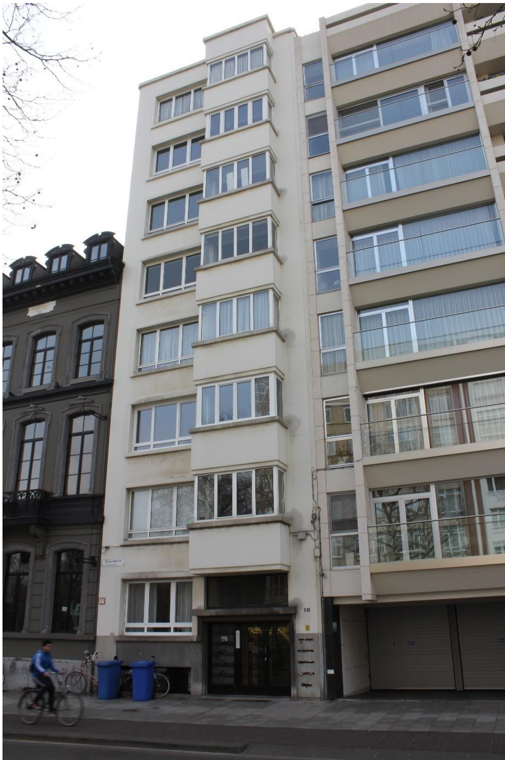
FIGUUR 113 HUIDIGE SITUATIE, EIGEN FOTO
