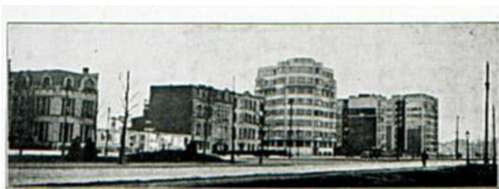
FIGUUR 52 HOOG- EN LAAGBOUW AAN DE JAN VAN RIJSWIJCKLAAN.
