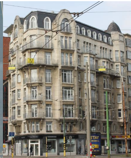
FIGUUR 30 HUIDIGE SITUATIE, EIGEN FOTO
