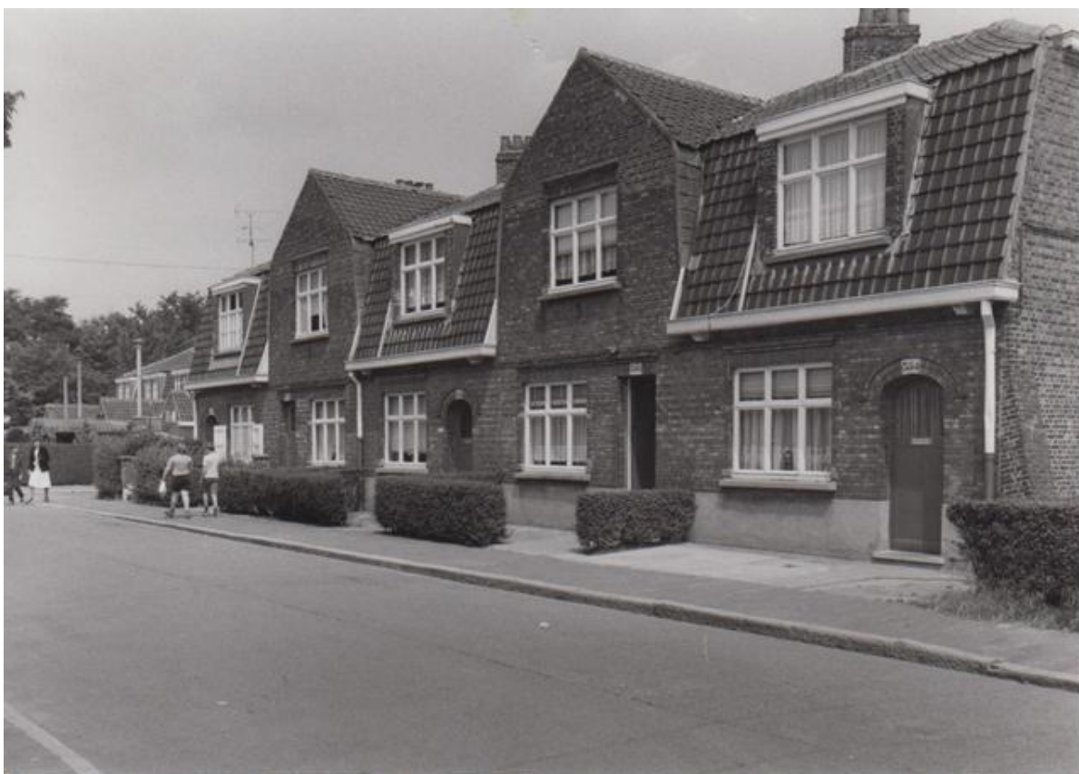
Afb. 1: Tuinwijk aan de Sint-Bernadettestraat, Sint-Amandsberg naar ontwerp van Oscar Van de Voorde
