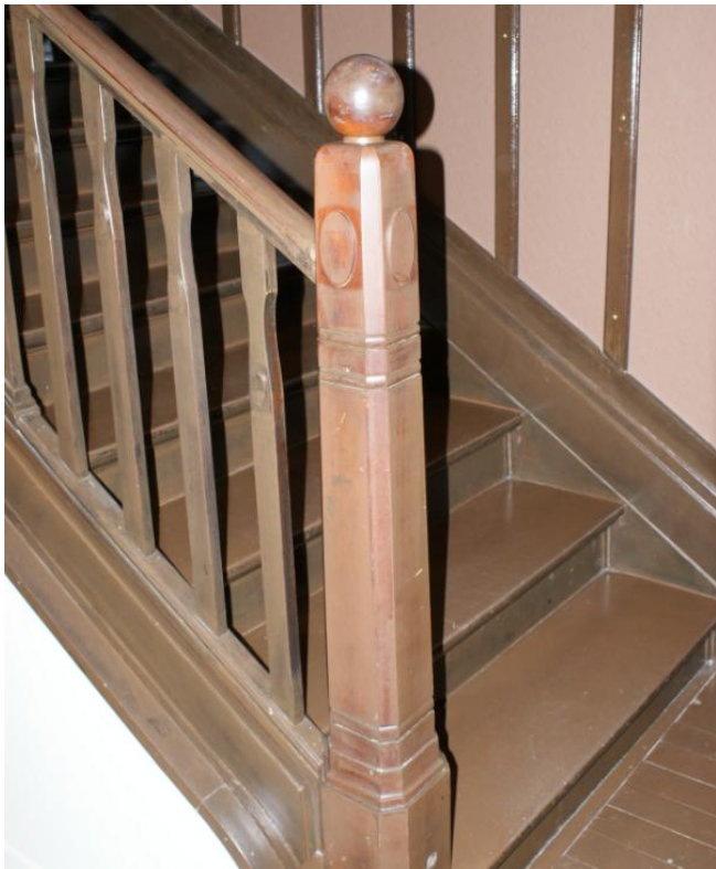
Afb. 101: Trap directeurswoning in Bank van de Arbeid Thomas De Keere, 2014
