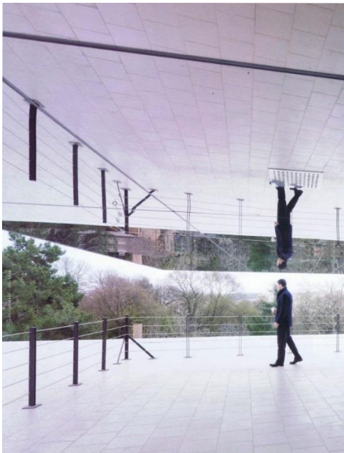
Zicht vanop het dakterras. 209
