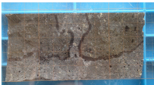
Afbeelding 41: Chloride-indringing in UHPC, met scheurvorming door warmtebehandeling
