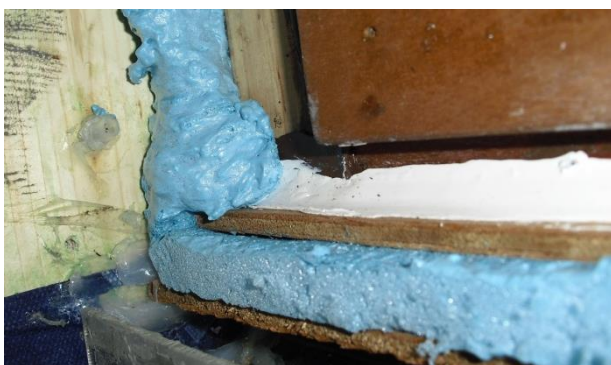
Afbeelding 148: luchtverliezen in linker onderhoek
