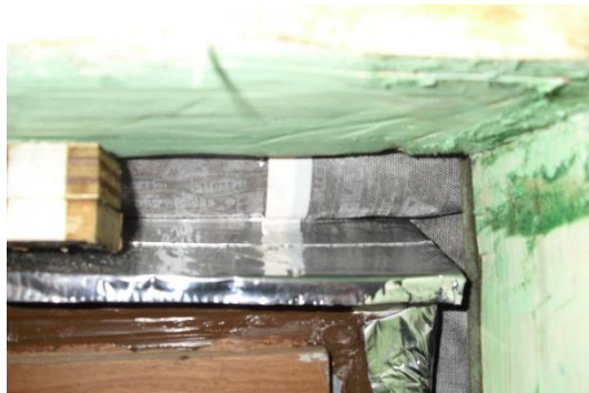
Afbeelding 137 en 138: afschot boven raam om infiltrerend water af te leiden
