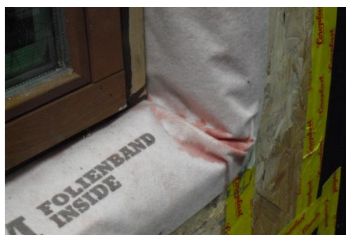
Afbeelding 62: waterinfiltratie hoeken onderaan
