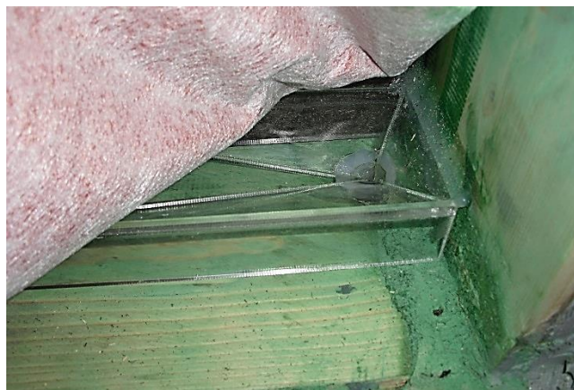
Afbeelding 64: Installatie gootje onder raam
