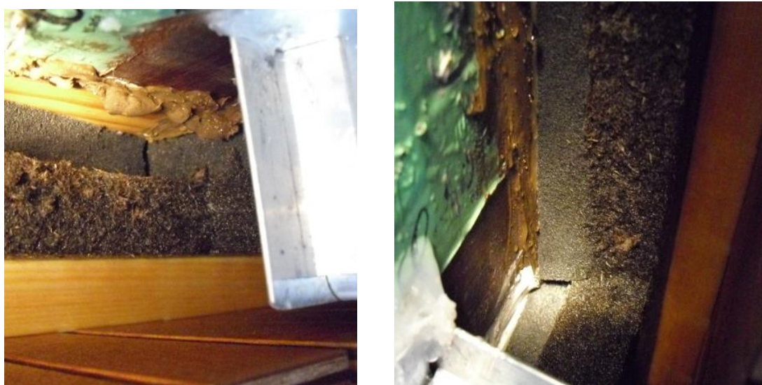
Afbeelding 95 en 96 : installatiemethode zwelband onderzoeken
