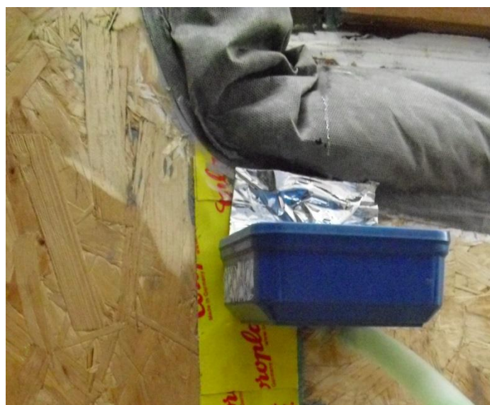
Afbeelding 100: water bovenop luchtdichtingsfolie Afbeelding 101: water bovenop luchtdichtingsfolie in hoek
