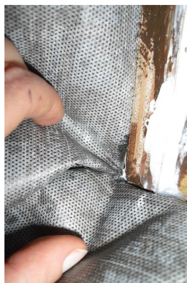
Afbeelding 100: water bovenop luchtdichtingsfolie Afbeelding 101: water bovenop luchtdichtingsfolie in hoek
