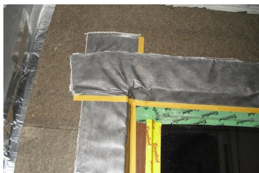
Afbeelding 109 en 110: verkleving overlap aan voorzijde raamkader - verkleving met vouw aan zijkant raamkader
