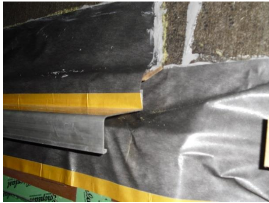
Afbeelding 135 en 136: aanpassing opstelling: gootje en opvang onderaan raamopening, druiplijst boven raam
