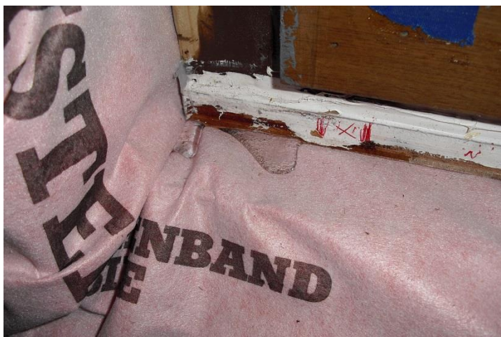
Afbeelding 123 en 124: waterinfiltratie tussen regendichting en raamkader, op de luchtdingsfolie
