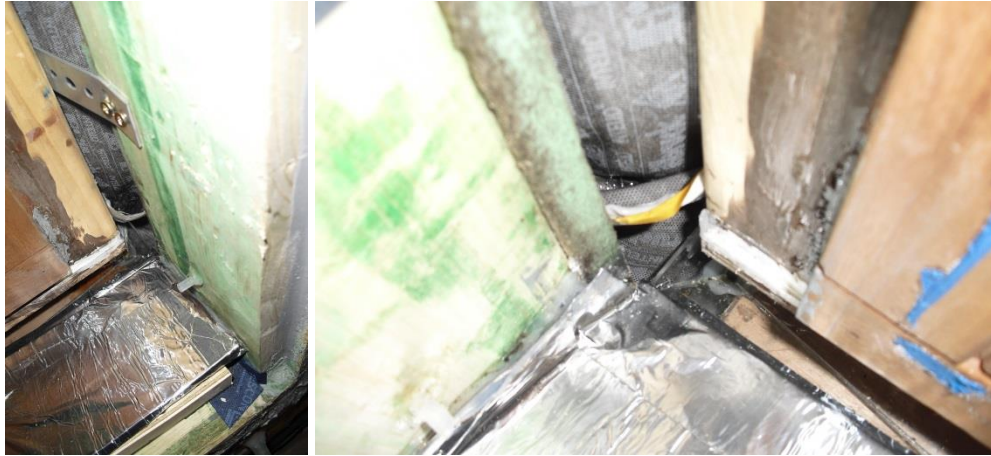
Afbeelding 142 en 143: ontstaan 'waterreservoir'
