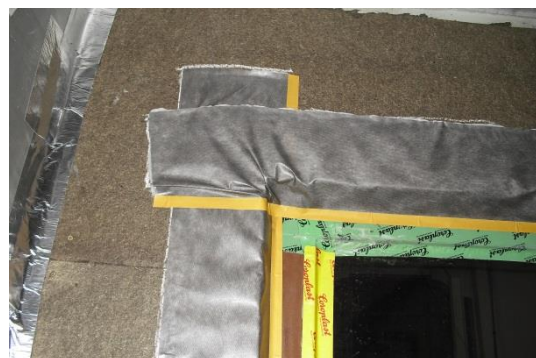
Afbeelding 129 en 130: uitvoering overlap met verkleving op voorzijde raamkader en continu met verkleving op zijkant raamkader
