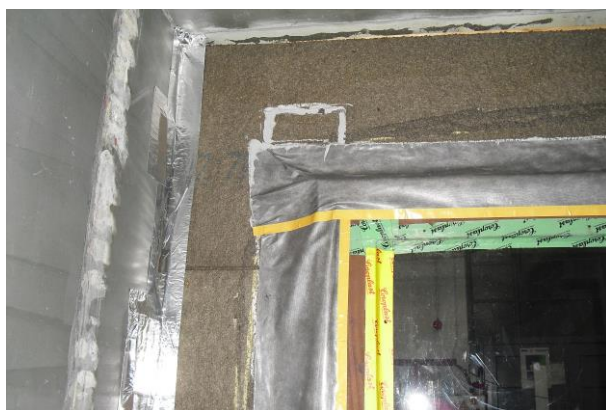
Afbeelding 161: aansluiting folie overlap, raam uit vlak regendichting
