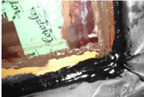
Afbeelding 126: silicone op voeg raam-folie
