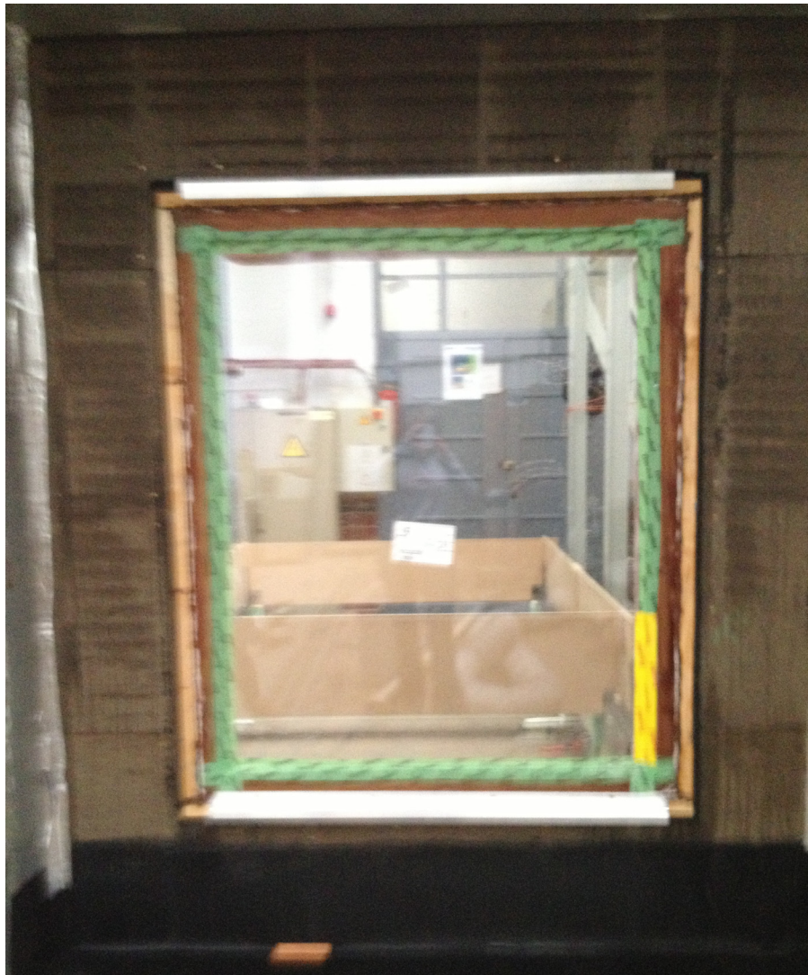
aanzicht buitenomgeving na verwijderen gevel
