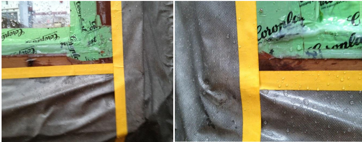
Afbeelding 144 en 145 : mogelijke oorzaken van waterinfiltratie tussen de overlap
