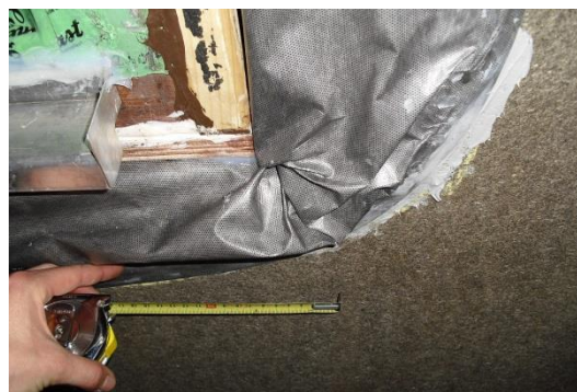
Afbeelding 129 en 130: uitvoering overlap met verkleving op voorzijde raamkader en continu met verkleving op zijkant raamkader
