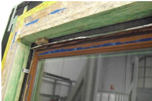
Afbeelding 137 en 138: afschot boven raam om infiltrerend water af te leiden
