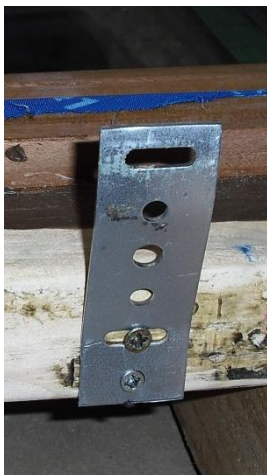
Afbeelding 147: plaatsing raamankers aan de rechterzijde
