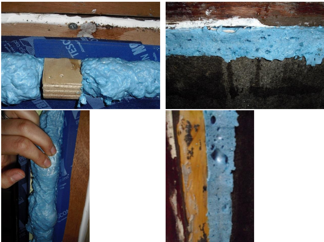
Afbeelding 153 en 154: Blokje onderaan rechts en doorheen multiplexkaderbevestiging + achterliggende oorzaak.
