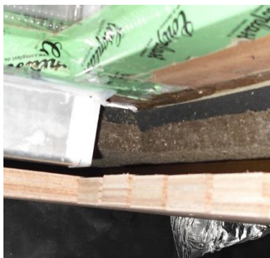
Afbeelding 92: installatiemethode zwelband onderhoeken
