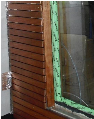
Afbeelding 115: installatie afwerkingslat
