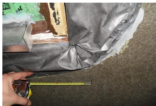
Afbeelding 109 en 110: verkleving overlap aan voorzijde raamkader - verkleving met vouw aan zijkant raamkader
