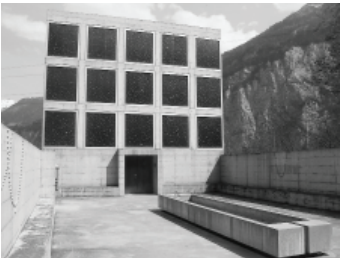
Afbeelding 92. Project nr.26. De kapel vanop het afgesloten voorplein. Het voorplein is een essentieel element voor de beleving van de binnenruimte.
