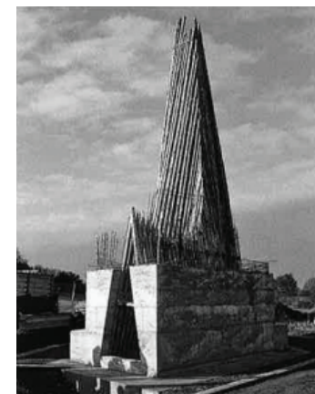
Afbeelding 82. De kapel in aanbouw
