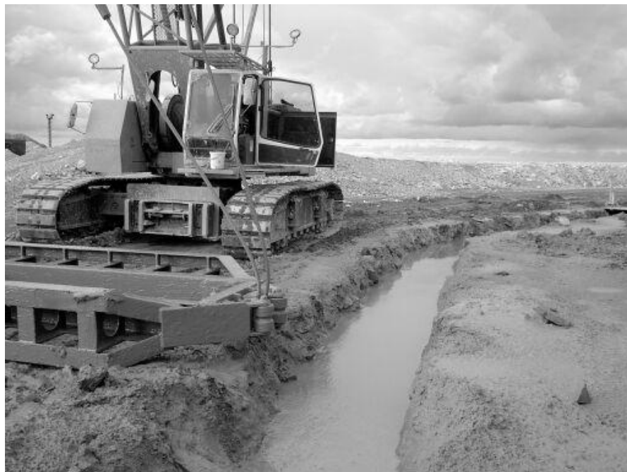
Figuur 4: Vervaardiging van een SCB-schermwand [4]
