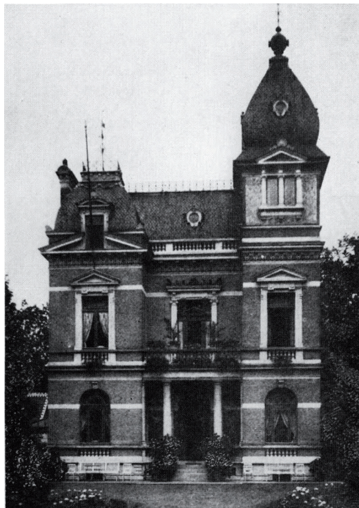
Fig 71. Het 'Kasteel Du Puits' uit 1898 was één van de talrijke kleinere zomerverblijven in neorenaissancestijl langs de Kortrijkse Steenweg in Sint-Denijs-Westrem
