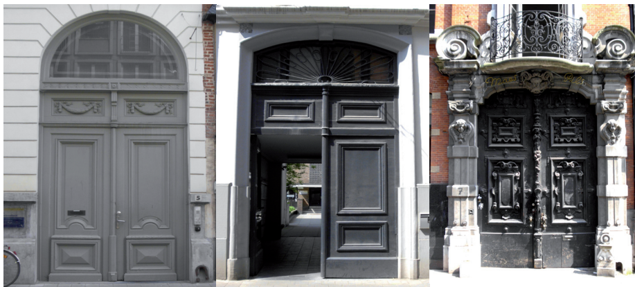
Fig 37.L: Neoclassicistische poort zonder omlijsting M: Neoclassicistische poort met bepleisterde omlijsting R: Neobarokke poort met omlijsting in blauwe hardsteen
