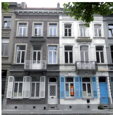
Fig 35. Twee identieke woningen waarvan het linker werd uitgevoerd in 'schoonwerk' en het rechter voorzien werd van een pleisterlaag als afwerking
