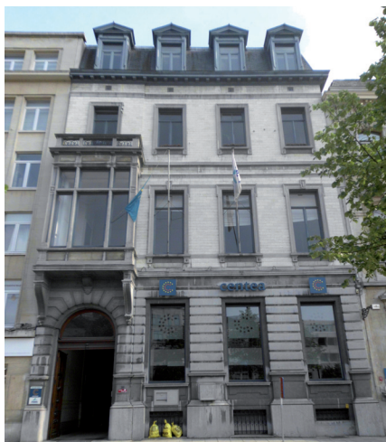
Fig 34. Twee woningen volgens de verplichte kleurstelling: de linker woning met plint in blauwe hardsteen en bepleisterd parement, de rechter woning met plint in blauwe hardsteen en parement uit witte natuursteen met vensteromlijstingen in blauwe hardsteen
