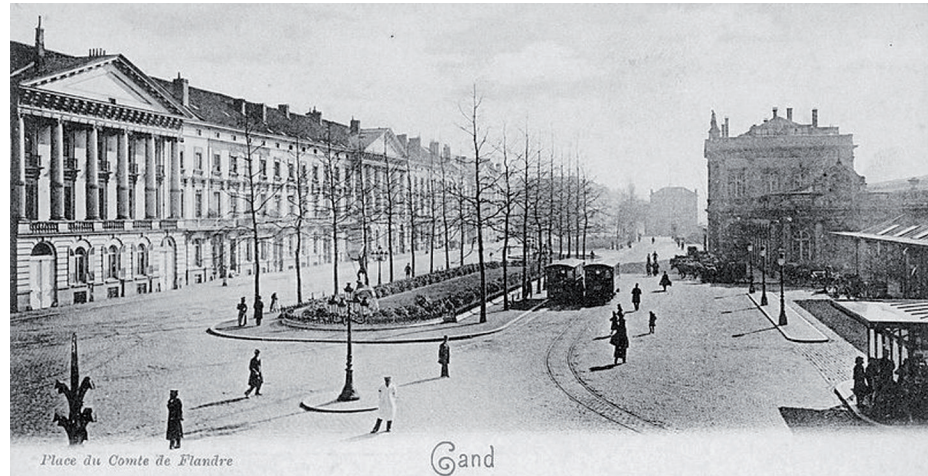
Fig 28. Het Graaf van Vlaanderenplein met aan de linkerkant de door Charles Leclerc-Restiaux ontworpen gevelwand uit 1847
