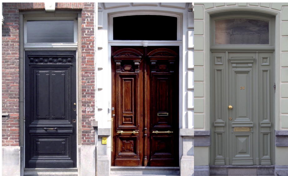
Fig 39.L: Neoclassicistische deur met panelen met ingesnoerde hoeken M: Neoclassicistische dubbele deur R: Neoclassicistische deur met drieledige indeling
