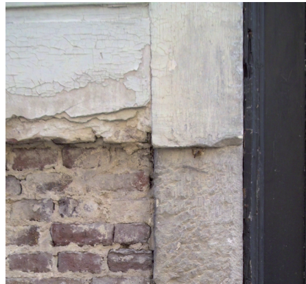
Fig 33. Metselwerk en blauwe hardsteen hoekblok bedekt met een pleisterlaag om een uniform uitzicht te verkrijgen
