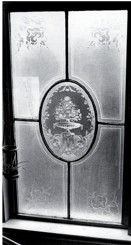
Fig 93. Traplicht met panelen in gezandstraald glas
