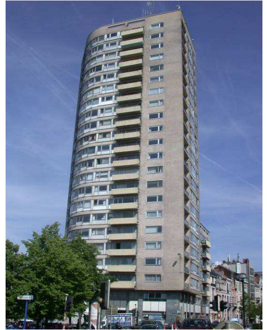
Figuur 8: Zuid gevel Royal building
