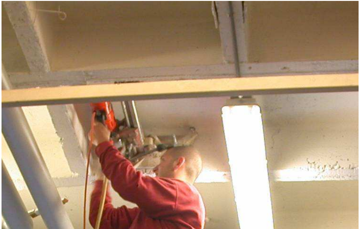
Figuur 27: Het halen van kernen uit het balkenrooster van ‘Les ateliers Delle’ in Ukkel
