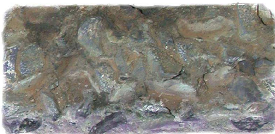
Figuur 56: Chloride-indringing na CTH proef bij alkali-geactiveerd slakkenbeton BA (kern afkomstig uit de buitenzone)
