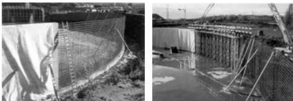
Figuur 7: Betonwand na ontkisting beschermd met behulp van een zeil (Ployaert, 2010)
