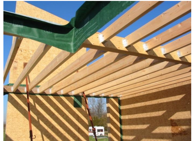
Fig 22 Vereenvoudigde vloer-wandverbinding volgens de ballonbouwmethode [6]; foto van woning volgens ballonbouwmethode (Lab 15)
