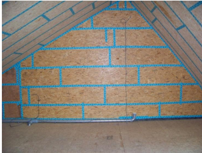
Fig 24 Luchtdichte aansluiting houtderivaatplaten (Lab 15)
