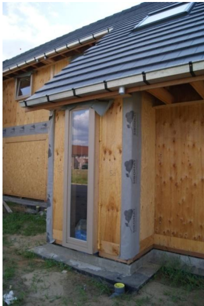
Fig 37 Bij de montage worden wachtfolies voorzien, die het onbeschutte hout (zie horizontale doorsnede op de detailtekening) afschermen (foto bouwplaats Sibomat in Heule; tekening bouwdetail Sibomat)
