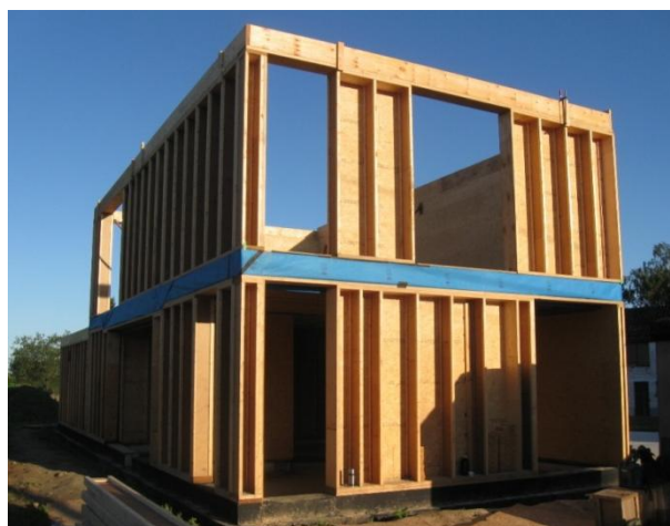
Fig 21 Vereenvoudigde vloer-wandverbinding volgens de platformbouwmethode [6]; foto van woning volgens platformbouwmethode (Lab 15)
