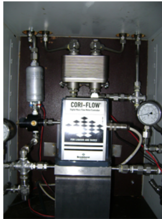
Figuur 6.22: Debietmeter Bronkhorst Cori-flow
