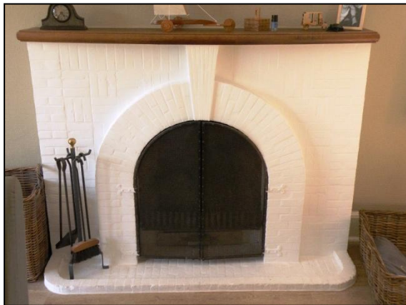
Foto 126 (boven): Haard in baksteenmetselwerk met subtiele art decotoets, villa “Les Pins”, Witteberglaan 13, De Panne. Eigen fotomateriaal (17/04/2011).
