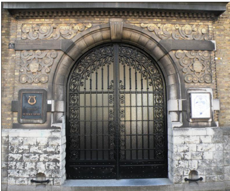
Foto 144: Sierlijk vormgegeven poort in smeedijzer, Nationale Bank, Noordstraat 16-18, Veurne. Eigen fotomateriaal (23/03/2011).
