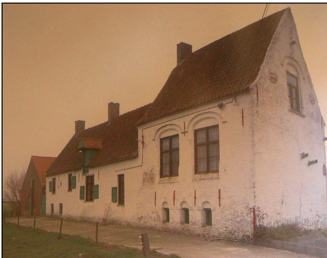
Foto 47: Traditionele hoeve “Kleine Eversam” te Stavele (1642). Opkamer met verspringende bedaking en opvallende vensternissen.
