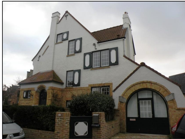
Foto 13: Rationalisme afleesbaar in de gevel van villa "Les Pins" in De Panne. Eigen fotomateriaal (12/03/2011).
