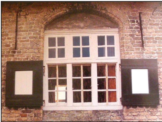
Foto 46: Een typisch 17 de -eeuws opkamervenster: houten kozijn met drielicht in een geprofileerde, korfbogige nis, geflankeerd door wit-groen geschilderde zijluiken.
