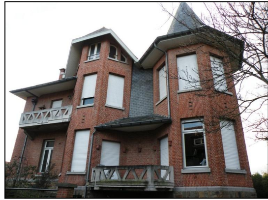
Foto 112: Oostgevel van villa “Castel Mino” (1930) met geometrisch uitgewerkte balkonleuningen in gegoten cement. Eigen fotomateriaal (15/11/2010).
