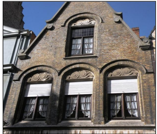
Foto 143: Vergelijkbare decoratie van gestileerde vegetatieve motieven in de segmentboogvormige vensteropeningen van Ooststraat nr. 6, Veurne. Ontwerp: A. Vandenabeele (datum onbekend). Eigen fotomateriaal (12/03/2011).
