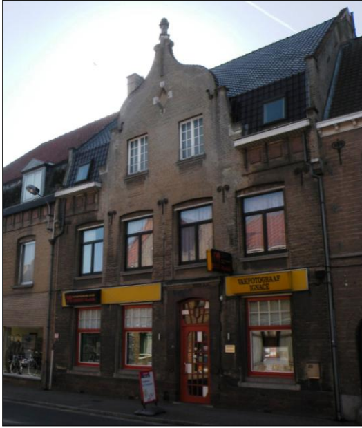
Foto 87: Voorgevel met verhoogde halsgevel, burgerhuis te Diksmuide, Adm. Ronarchstraat 25. Eigen fotomateriaal (17/04/2011).
