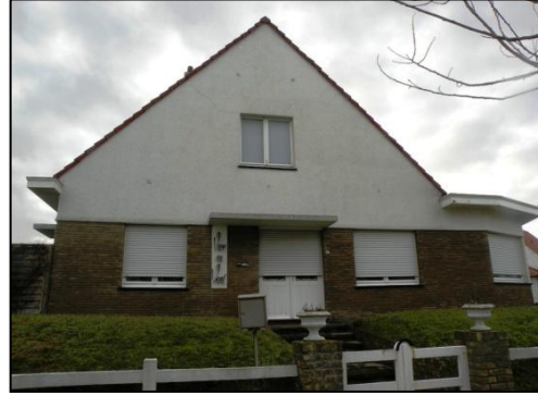
Foto 114 (onder): Voorgevel van de villa in de Koninginnelaan 39 te Koksijde. Opvallend is het contrast tussen de witte kleur van het gegoten cement en het gele baksteenmetselwerk.
