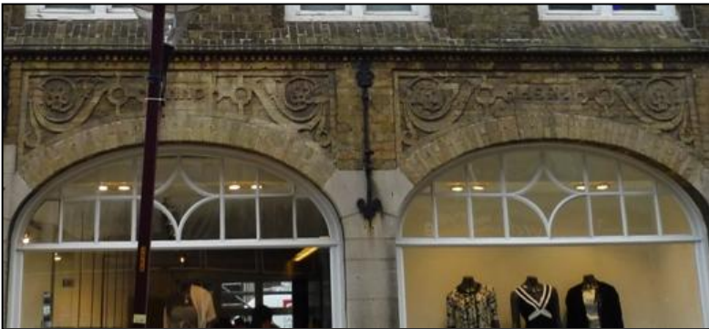
Foto 142: Decoratief metselwerk van gestileerde vegetatieve motieven boven de segmentboogvormige etalagevensters van hoekhuis, Ooststraat nr. 1, Veurne. Ontwerp: C. Van Elslande (1920). Eigen fotomateriaal (31/03/2010).
