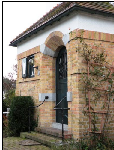
Foto 109: Erkervormig toegangsportaal van villa “Les Pins” met art-decovormgeving in geometrisch baksteenmetselwerk en hoekige aanzetstenen in natuursteen. Eigen fotomateriaal (14/12/2010).
