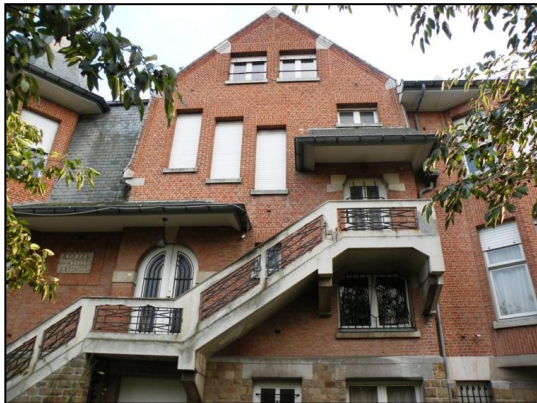
Foto 111: (onder): Centrale travee met puntgevel van villa “Castel Mino” (1930) met opvallende toegangstrap en getrapte vensterpositie. Eigen fotomateriaal (15/11/2010).
