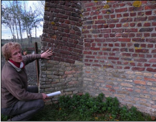
Foto 58: Contrast tussen de gele baksteen van de oorspronkelijke bouw en de rode baksteen van het heropgebouwde gedeelte. Plint van het boerenhuis. Hoeve de "Groene Poorte" te Pervijze. Eigen fotomateriaal (08/11/2010).
