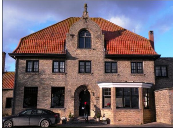
Foto 88: Overeenkomstige voorgevel met verhoogde halsgevel, boerenhuis, hoeve "de Groote Hemme", Ramskapelle. Eigen fotomateriaal (09/11/2010).
