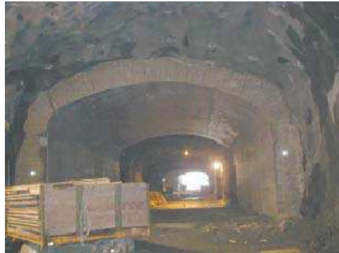
Figuur 4: Betonnen boog gebruikt in het Sodrä Länken project
