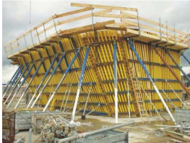
Figuur 7: Bekisting van 1 pilaar van het Phaeno Science Center
