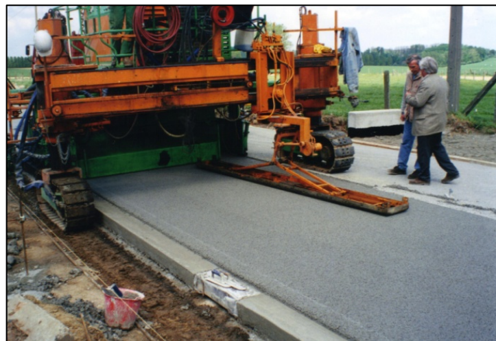
Figuur 80: Het aanleggen van het tweelaags DGB
