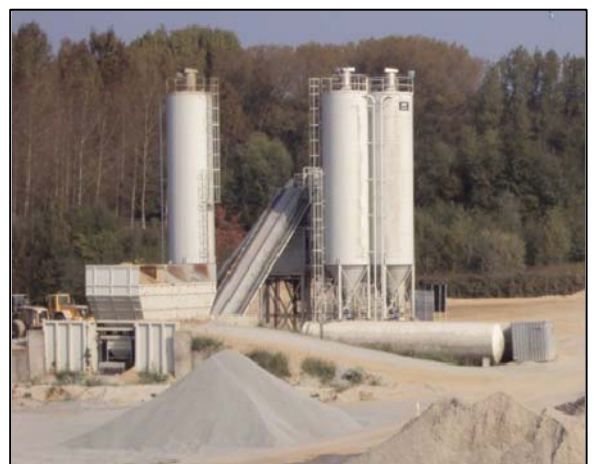
Figuur 51: De mobiele betoncentrale
