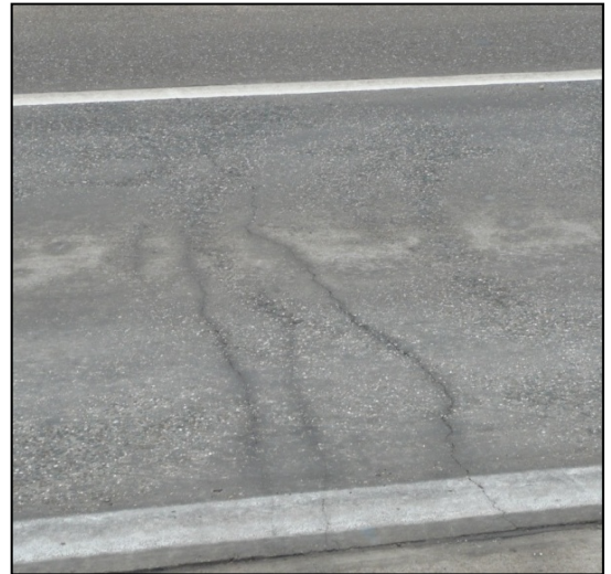
Figuur 21: Scheuren in een cluster [Bron: L.Rens]
