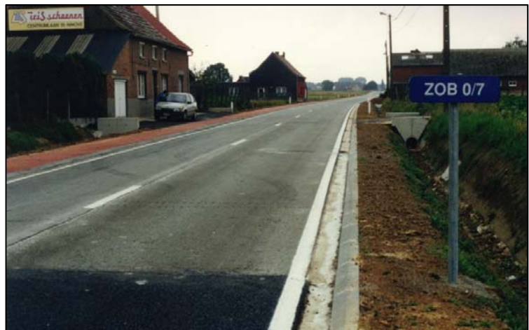
Figuur 76: De verharding met toplaag in zeer open beton
