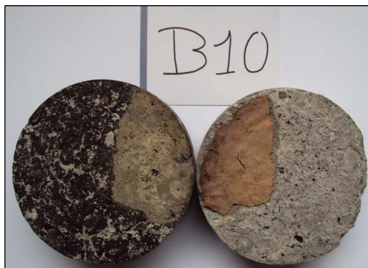
Figuur 58: Afschuifvlak beton / asfalt van boorkern B10
