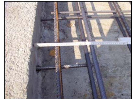
Figuur 7: Geboorde ankerstaven (werkvoeg)
