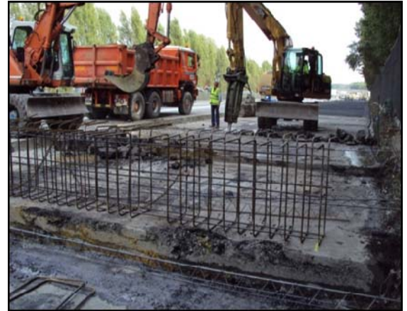
Figuur 5: De constructie van ribben op de E40 te Affligem
