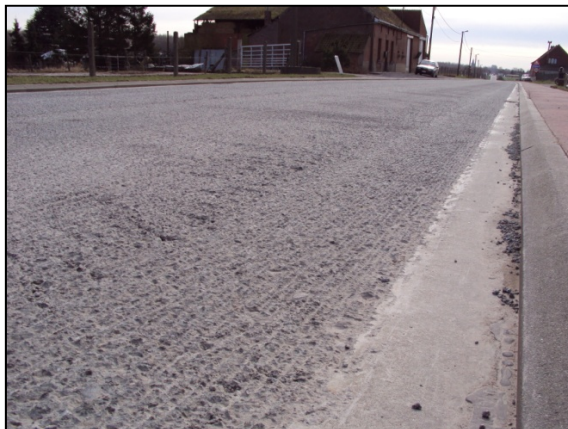
Figuur 83: Het ZOB werd afgefreesd in het voorjaar van 2010
