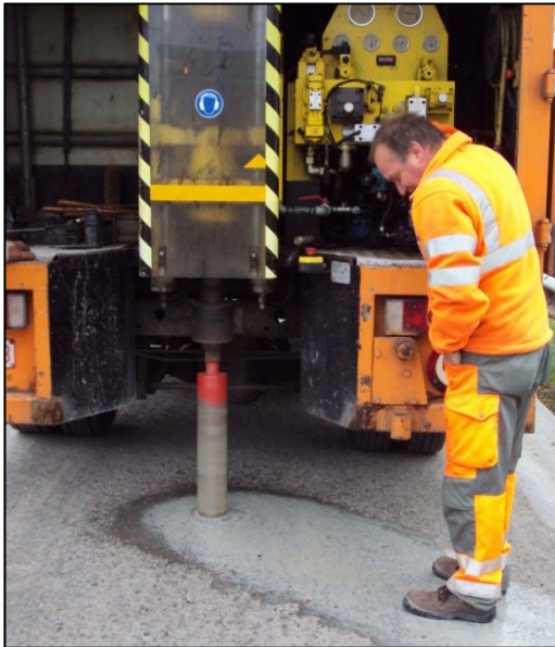
Figuur 53: Het boren van de kernen
