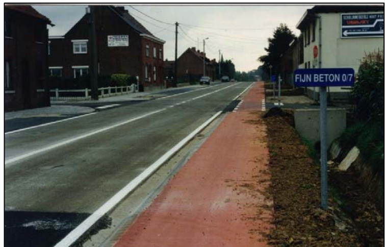
Figuur 75: De verharding met toplaag in fijn beton
