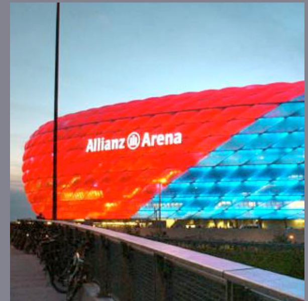
Figuur 2.16_ Allianz Arena < Herzog & de Meuron (Kronenburg, 2007)
