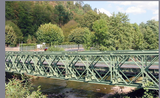
Figuur 3.2 Bailey Brug (www.essential-architecture.com)
