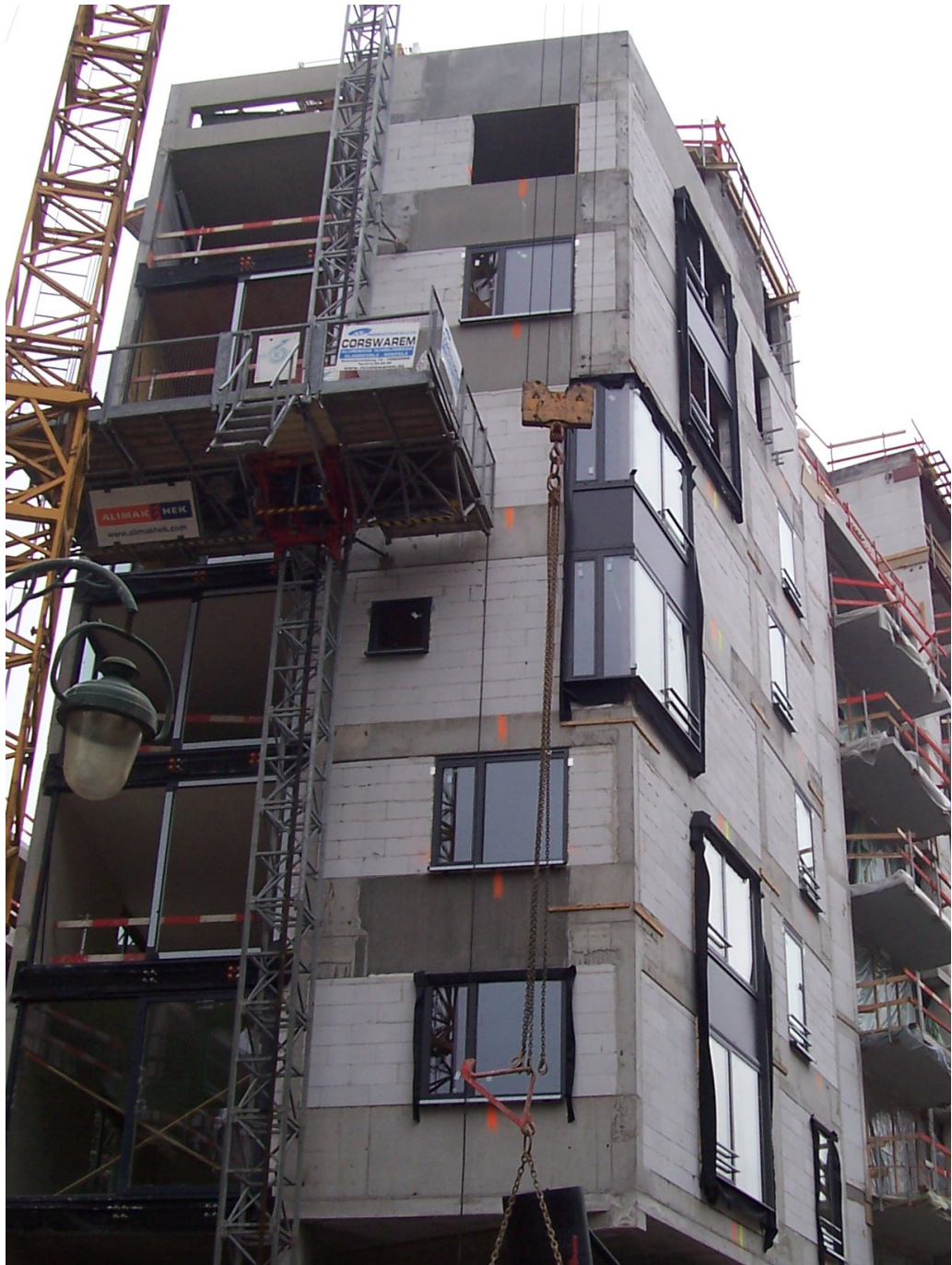
Fig. 2 Foto plaatsing membranen (nog niet verkleefd op ruwbouw) op de werf van Leopold Village, Brussel
