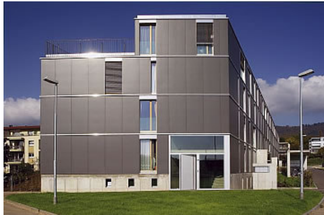
Figuur 35: Gevel met vezelcementpanelen (© www.aecinfo.be )
