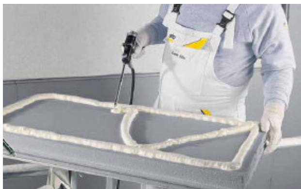
Figuur 41: Verlijmen met lijmpistool (© www.sto.be )
