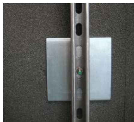
Figuur 44: Voorstelling bevestigingsrail en drukverdelingsplaatjes (© www.foamglas.be )
