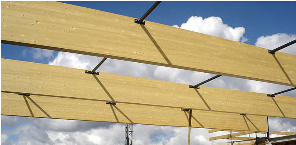
Figuur 55: Toepassing gelamineerde liggers (© www.hekospanten.nl )
