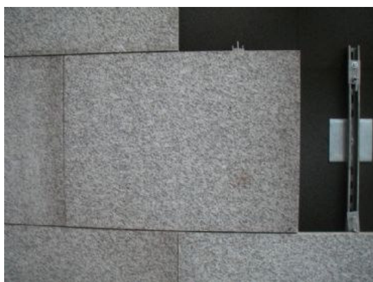
Figuur 44: Voorstelling bevestigingsrail en drukverdelingsplaatjes (© www.foamglas.be )
