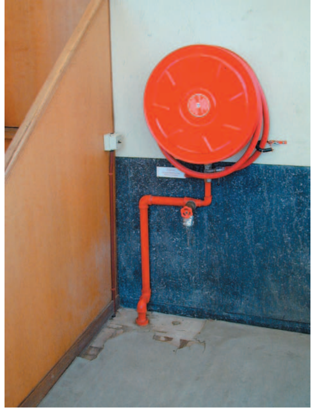
Brandslanghaspel voor marmerlambrisering (hier belvédère)
