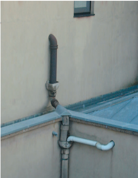
Regenwaterafvoer in verschillende materialen
