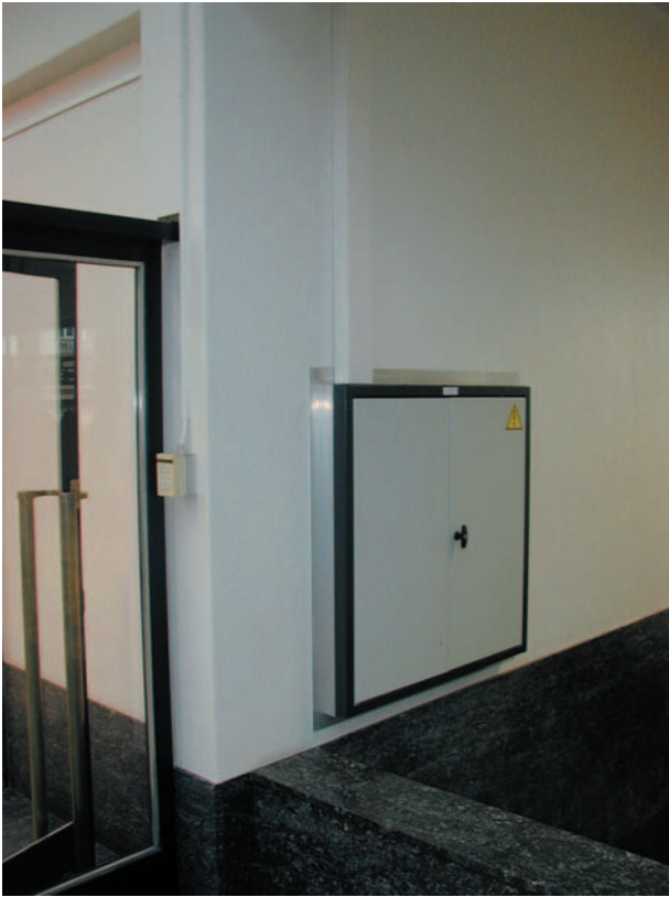
Opbouw Electriciteitskast en PVC goot (inkom bibliotheek)
