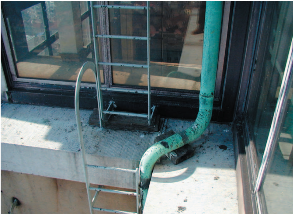
Dak Belvédère met landschap van antennes
