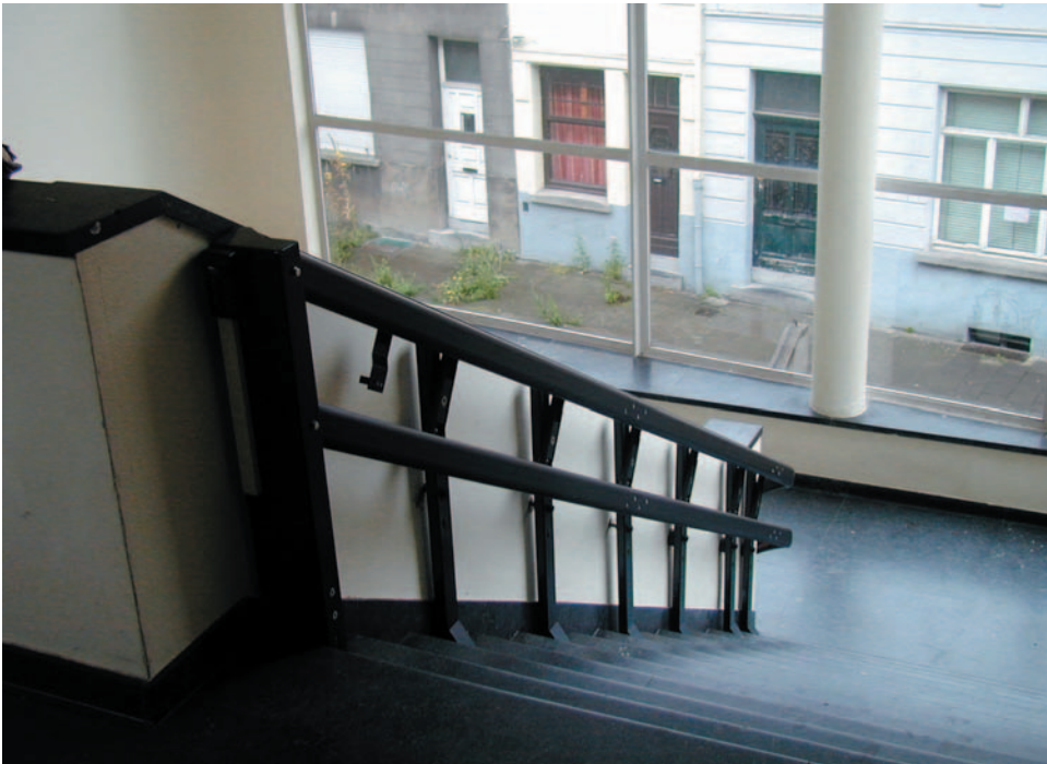
Rail van trapplateaulift
