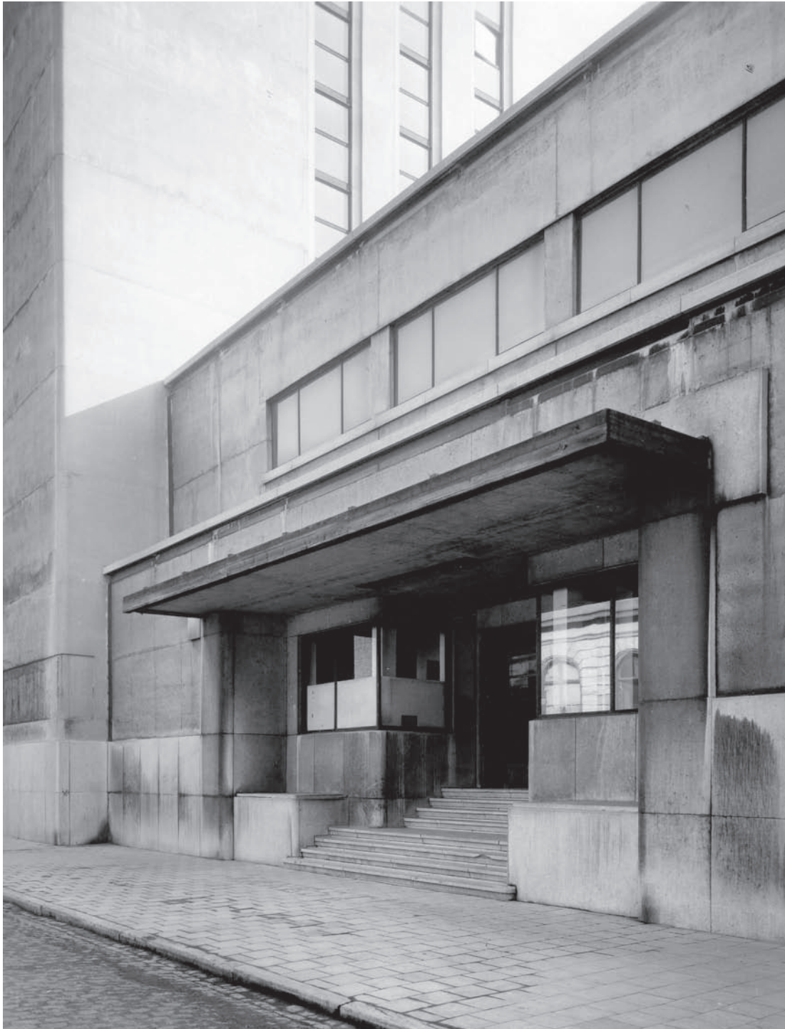
Foto Sergysels, 1947 - 1948 (Archief KBR): Houten plank is uitgevoerd, Bronzen dakrand (nog) niet
