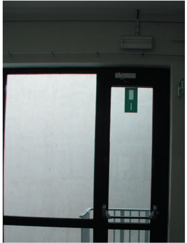
Aanpassing stalen kozijn met aluminium nooddeur
