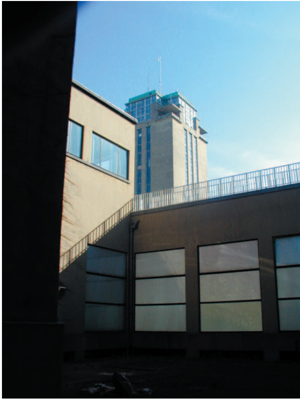
Evacuatiepasserelle aluminium
