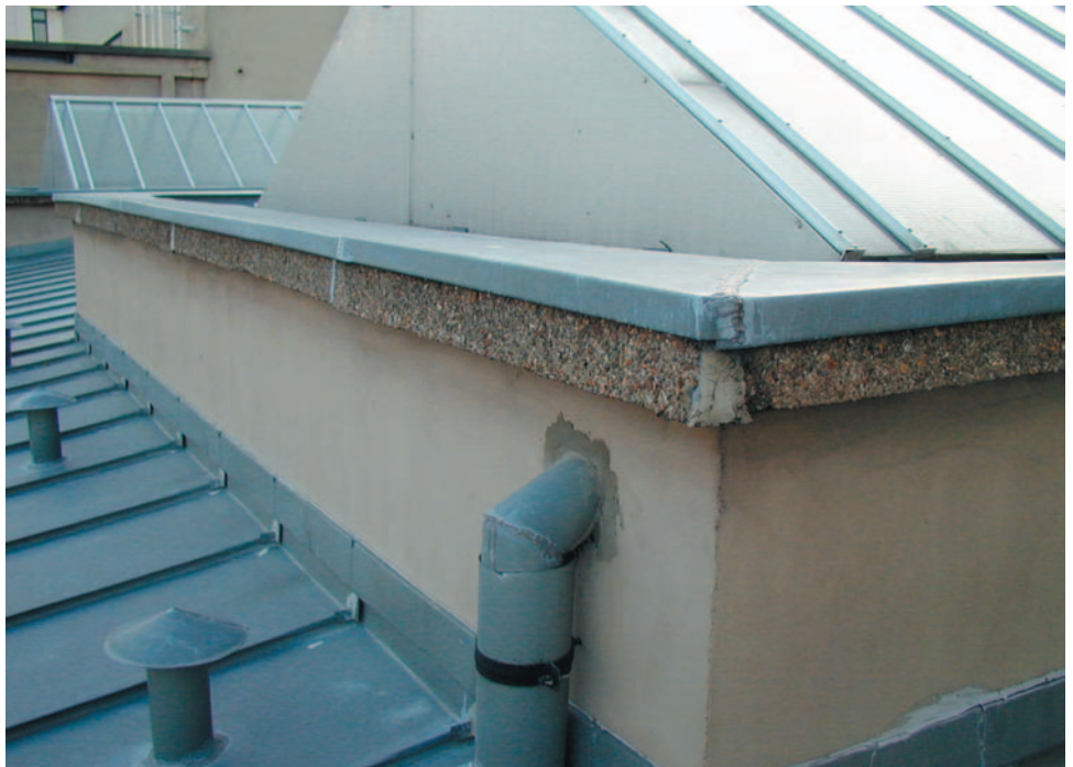
Details zink en glas zijn onverzorgd uitgevoerd
