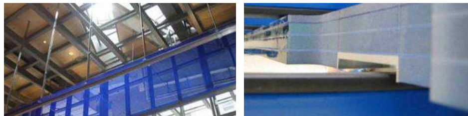
Figuur 1.27: Blauwe voetgangersbrug in het gemeentehuis van Seattle, VS, ontwerp: James Carpenter Design Associates (2002) en detail van een ingelamineerd aluminium U-profiel.
