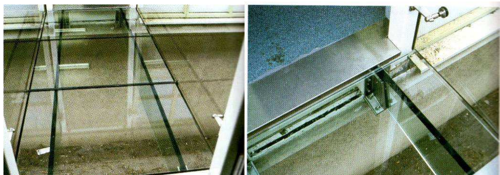
Figuur 1.25: lineaire adhesieve verbinding tussen liggers en vloerplaat bij de glazen voetbrug in Rotterdam, Nederland (1994) 2 .
