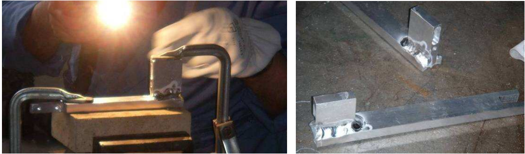
Figuur 4.19: lassen van de L-vormige metaalelementen.
