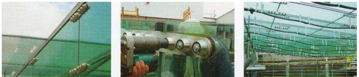
Figuur 1.13: afgeronde voorspanplaten bij de glazen liggers van Wolfson Ziekenhuis van de universiteit van Glasgow, Groot-Brittanië (2002) 3 .
